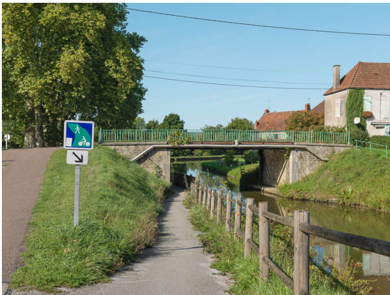
Vue d'ensemble du pont.
