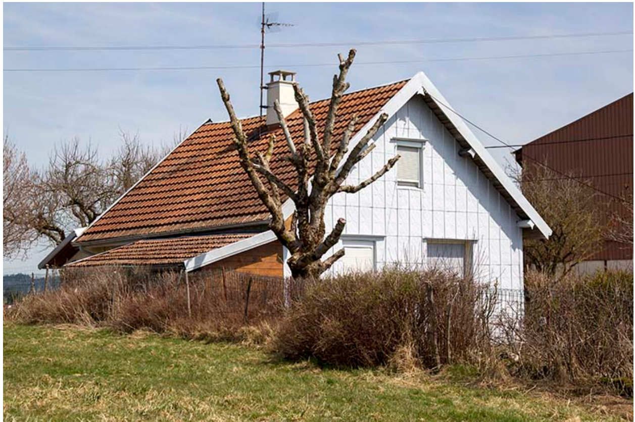
Façades postérieure et latérale gauche.
