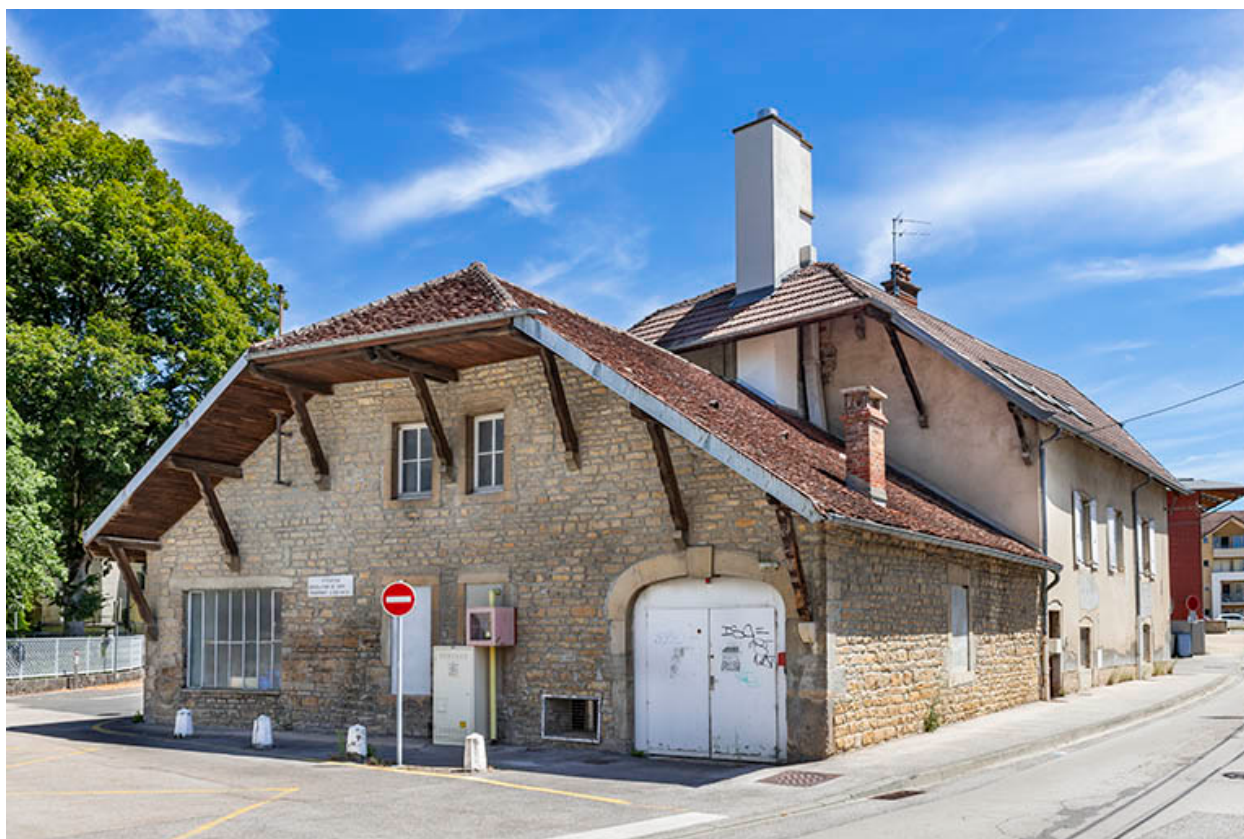
Vue depuis l'ouest.
