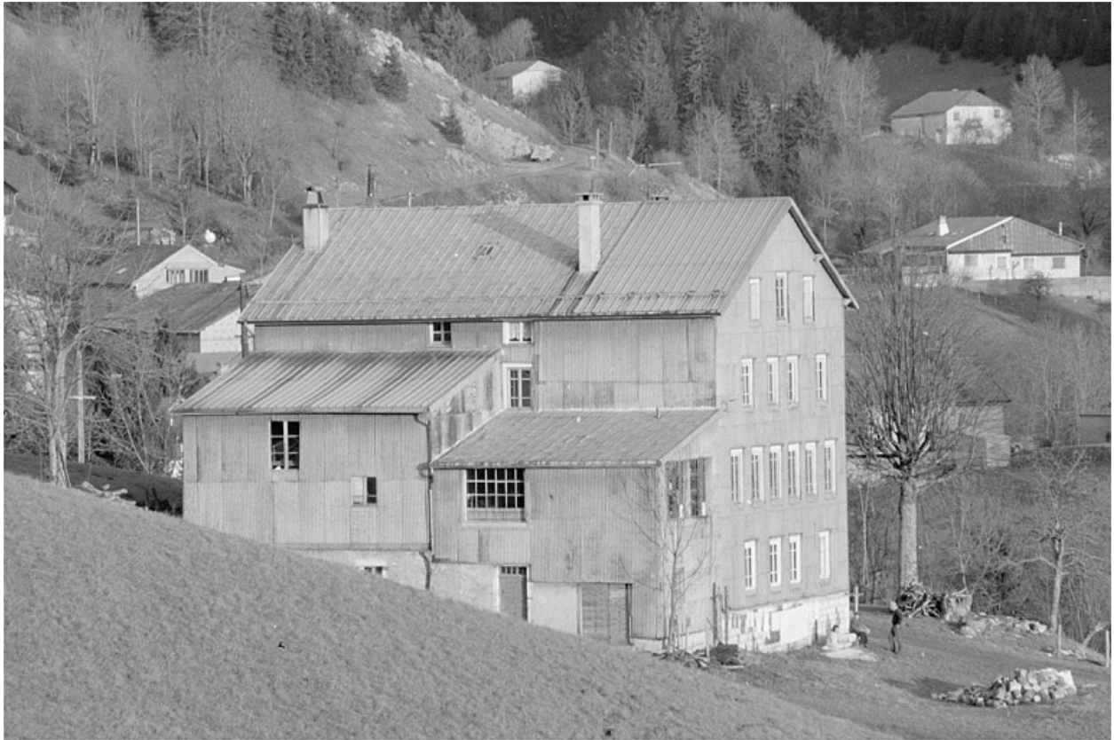
Façades postérieure et latérale droite.
