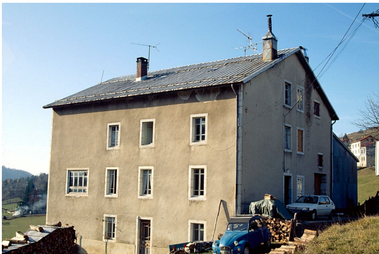
Façades antérieure et latérale gauche.
