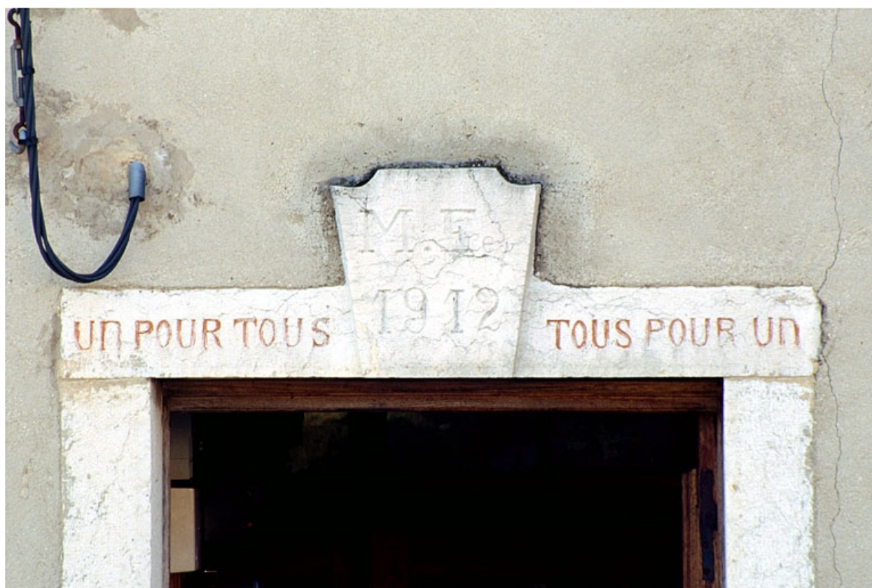
Linteau de la porte d'entrée.
