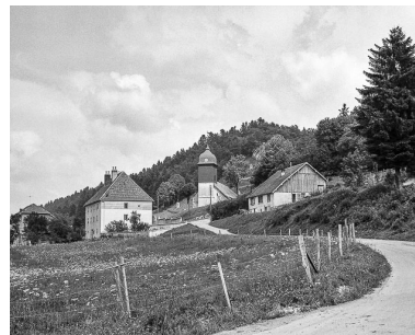
Vue de situation. Phot. Yves Sancey IVR43_19752500549X
