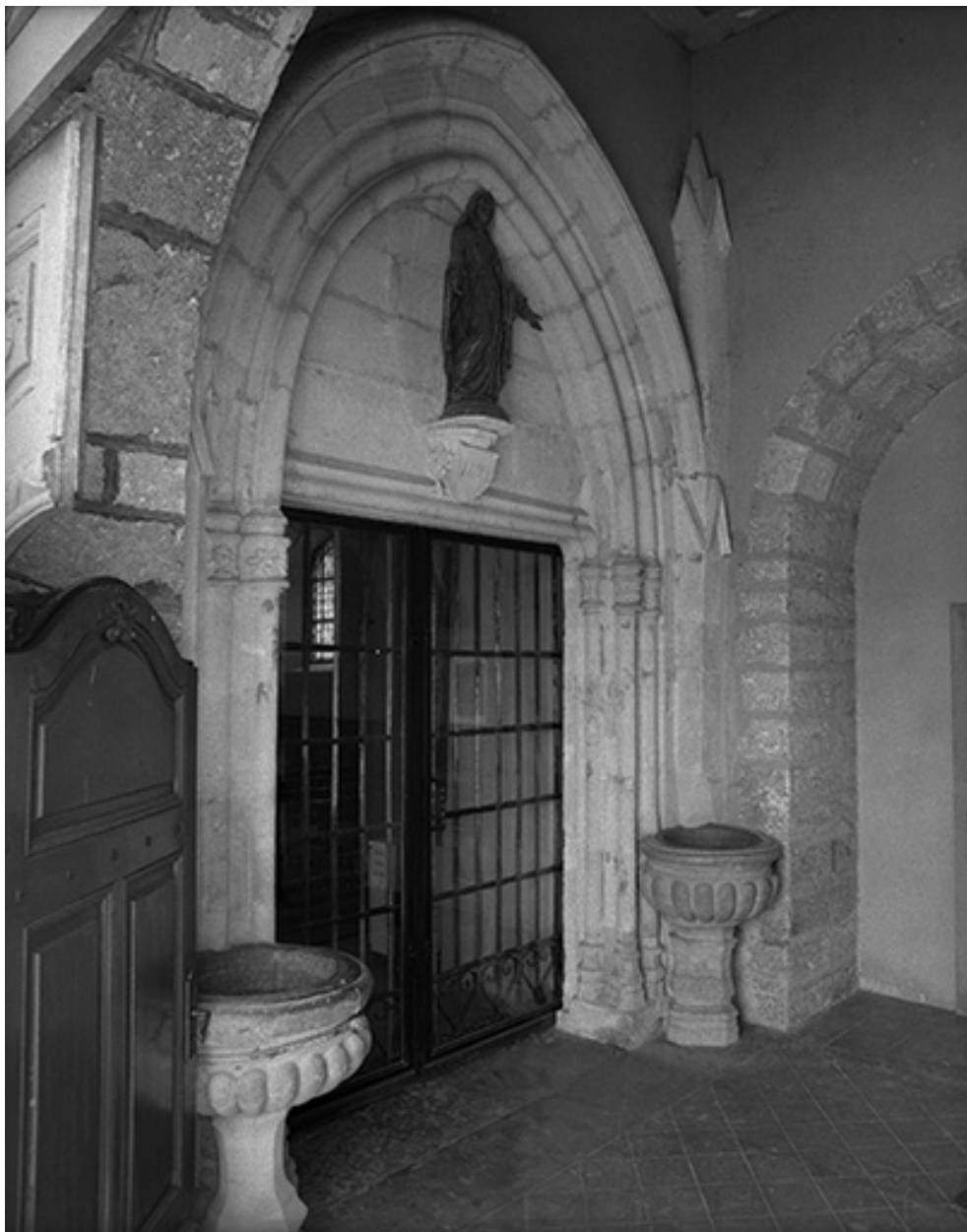
Portail d'entrée depuis la nef.
