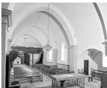
Nef vue depuis le chœur.
