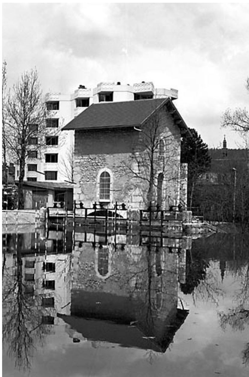
Bâtiment d'eau (local de la turbine) en 1980.
