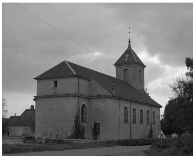
Face postérieure et face latérale gauche. Phot. Yves Sancey IVR43_19757000161X
