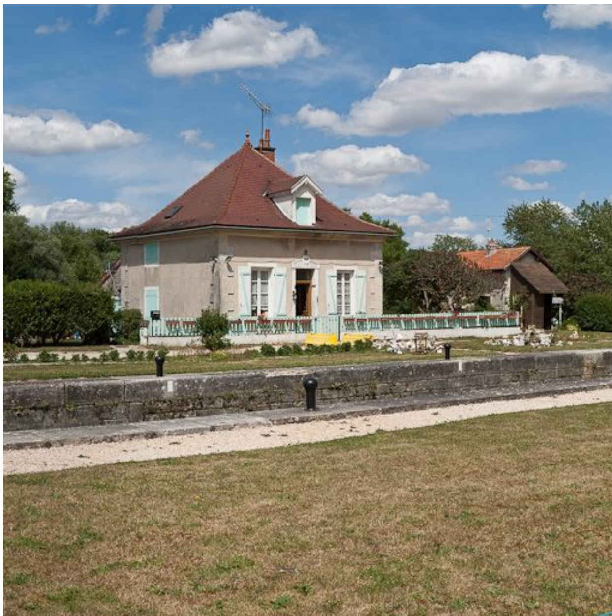
Vue de la maison éclusière.
