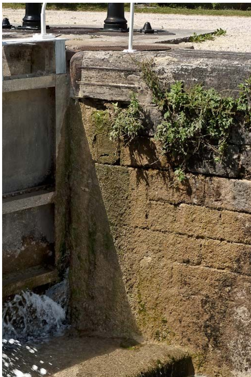
Détail de la maçonnerie du sas d'écluse.
