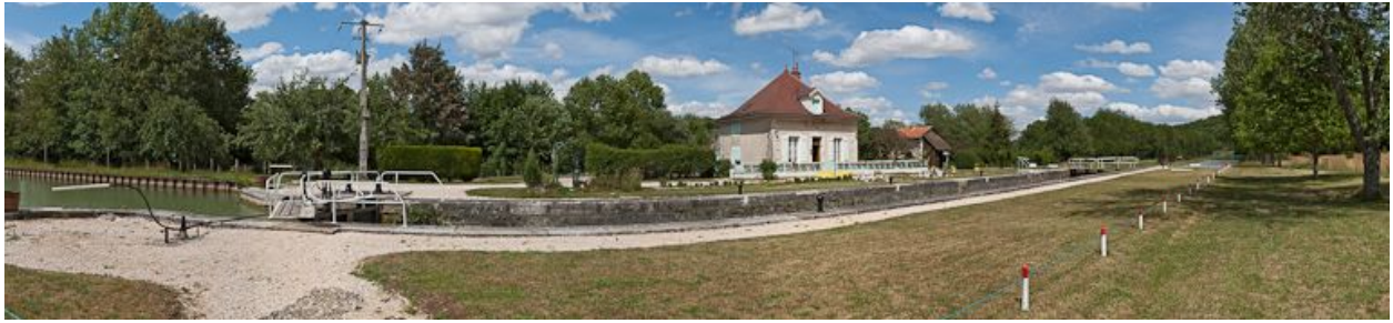
Vue d'ensemble du site d'écluse.
