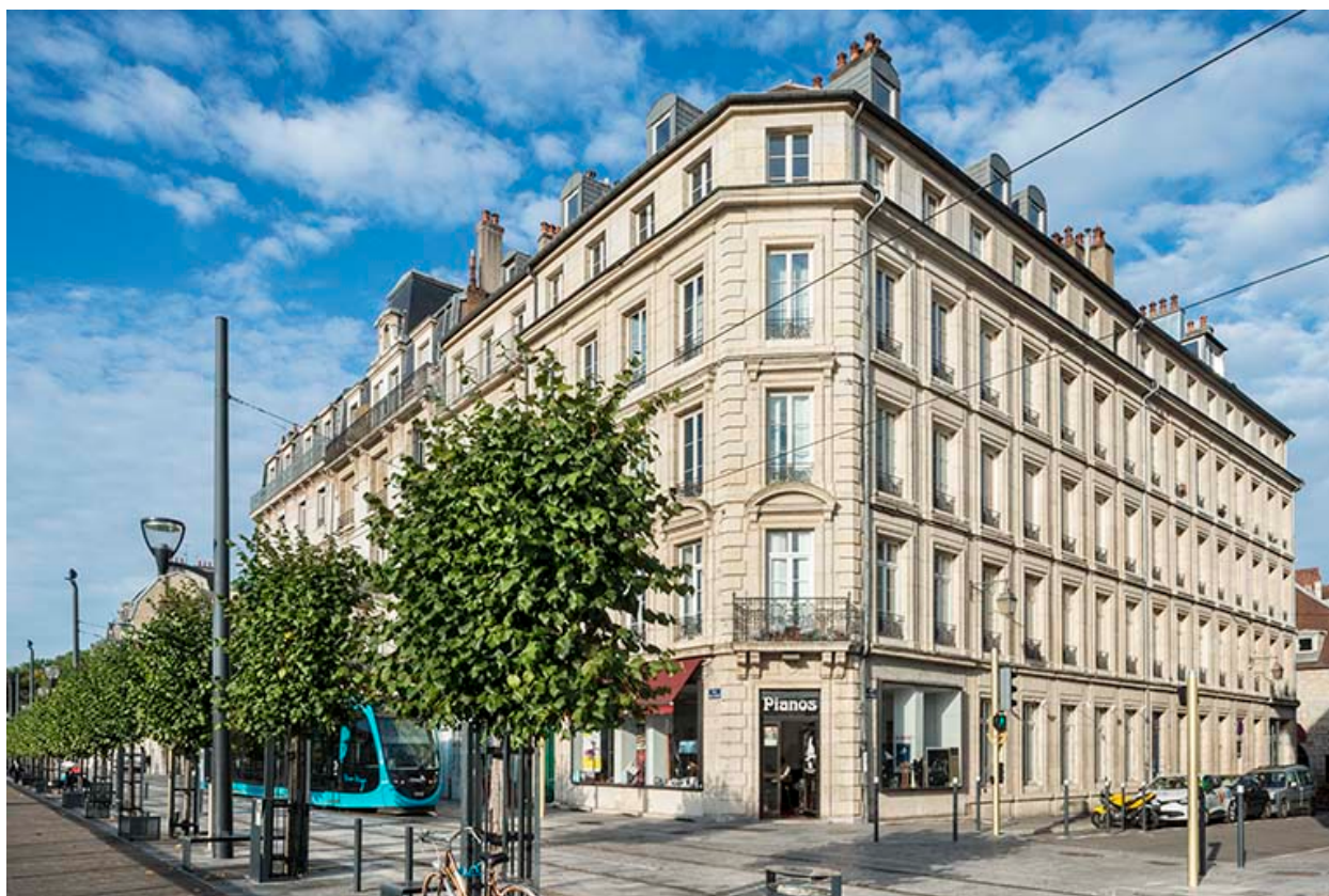
Vue d'ensemble depuis le quai Veil-Picard.
