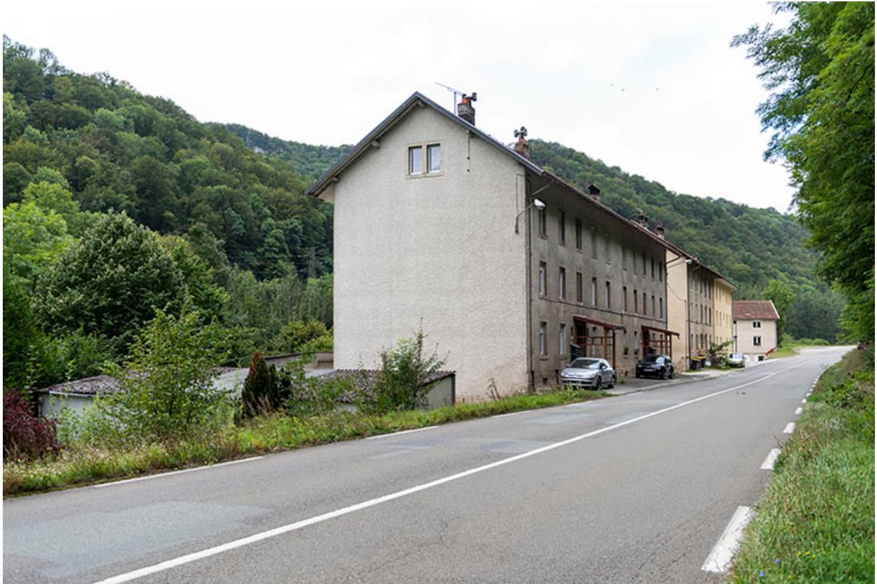
Vue d'ensemble, depuis la route à l'est.
