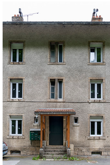
Immeuble, façade antérieure : entrée du n° 10.
