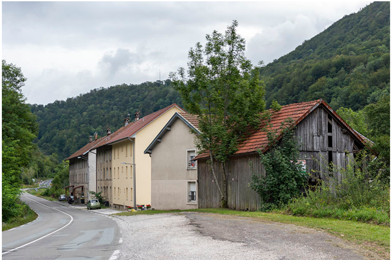
Vue d'ensemble, depuis la route à l'ouest.
