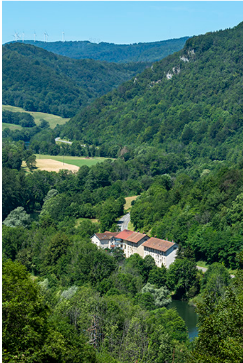
Vue d'ensemble plongeante, depuis le sud-est.
