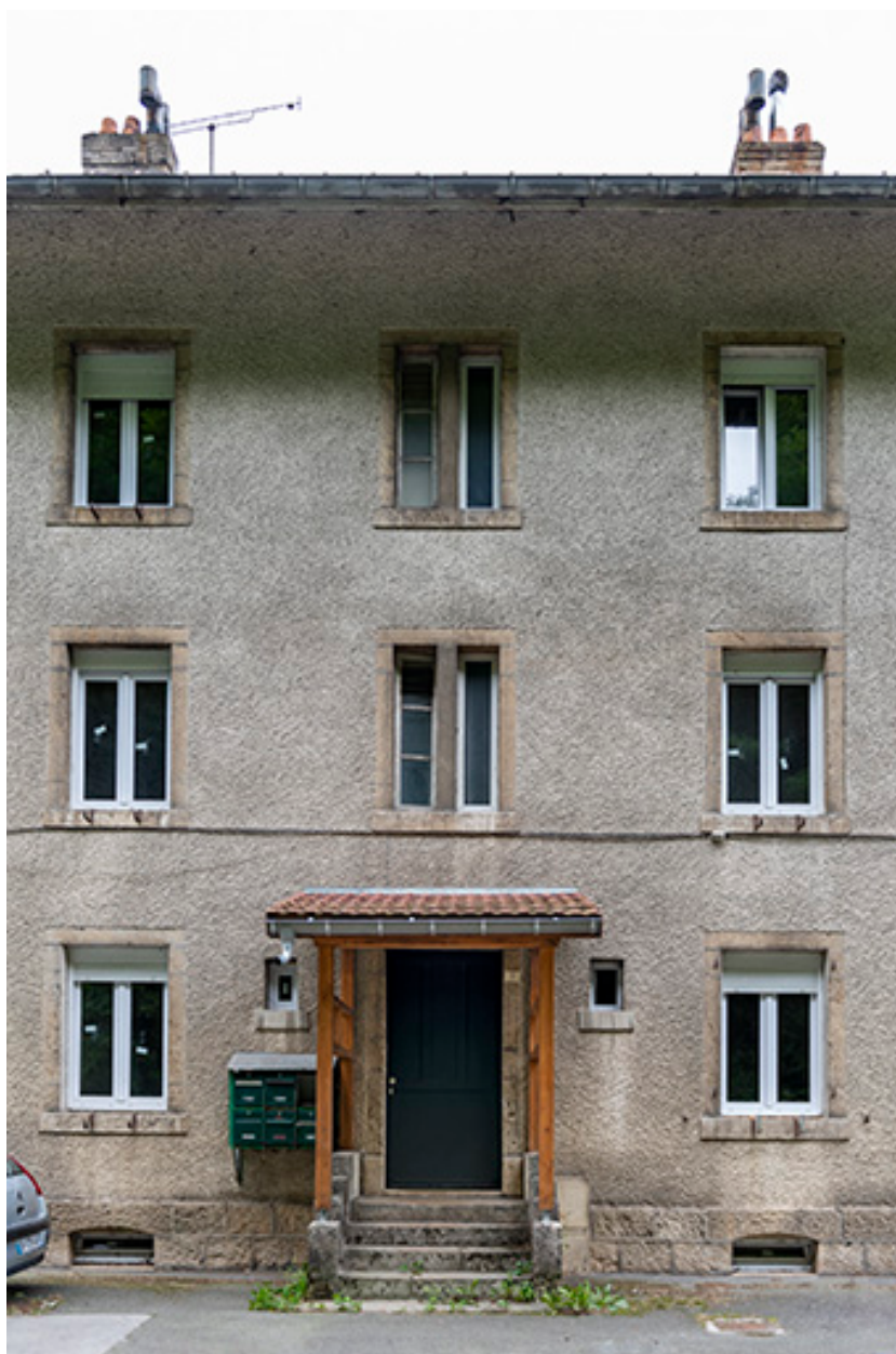
Immeuble, façade antérieure : entrée du n° 10.
