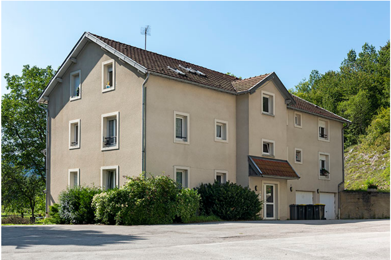
Maison : façades antérieure et latérale gauche.
