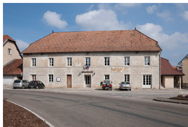
Façade antérieure. Phot. Jérôme Mongreville IVR43_20162500214NUC4A
