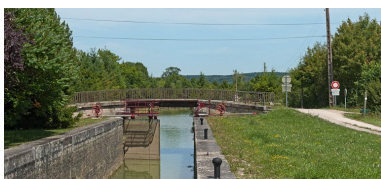
Vue du pont depuis l'amont.
