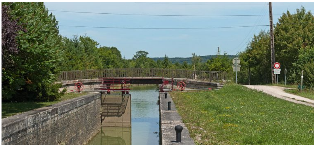
Vue du pont depuis l'amont.
