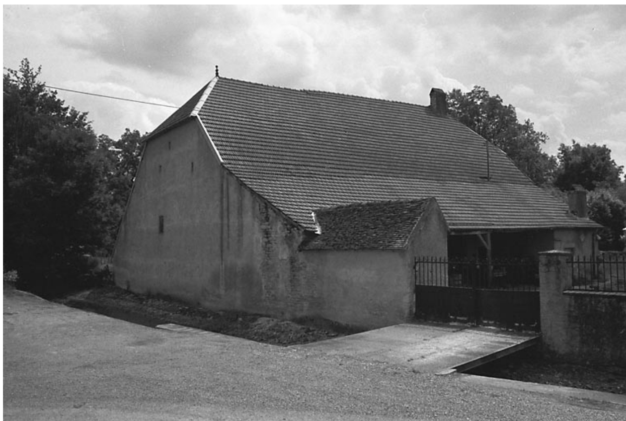
Façades antérieure et latérale gauche.
