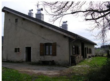
Façade latérale. Phot. Marie-Pierre Reynet IVR43_20083900179NUC1A
