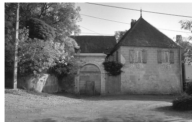
Façade sur rue. Phot. Bernard Lardière IVR43_19797000415Z
