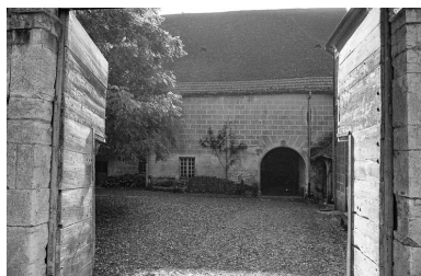
Façade sur cour. Phot. Bernard Lardière IVR43_19797000416Z
