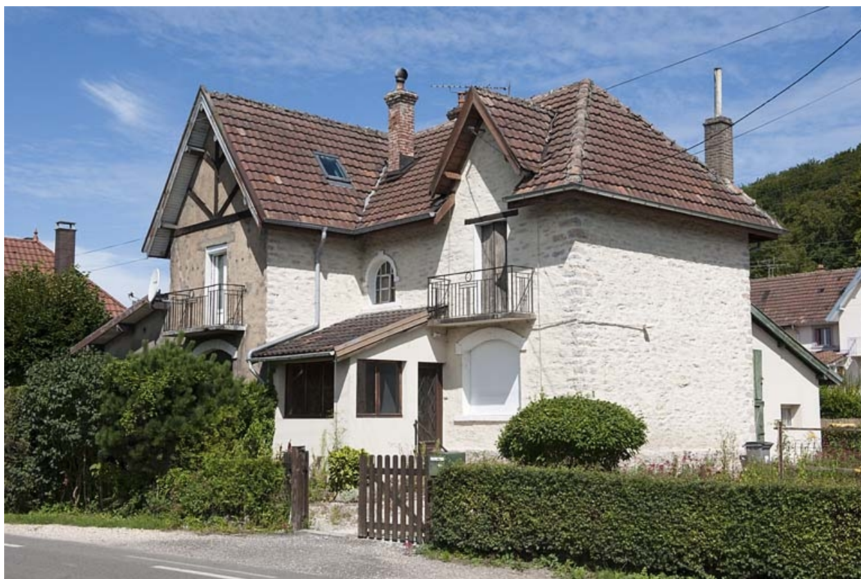
Maison de contremaîtres vue de trois quarts.
