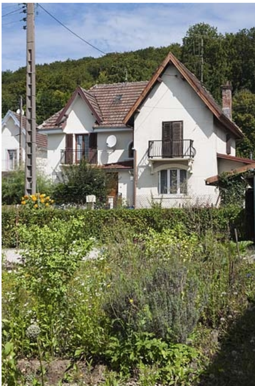
Maison de contremaîtres (n°4-6).
