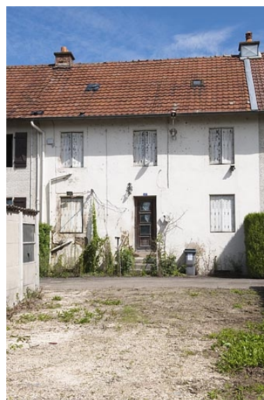
Habitation de 10 logements. Détail d'une travée. Phot. Jérôme Mongreville IVR43_20112502154NUC4A
