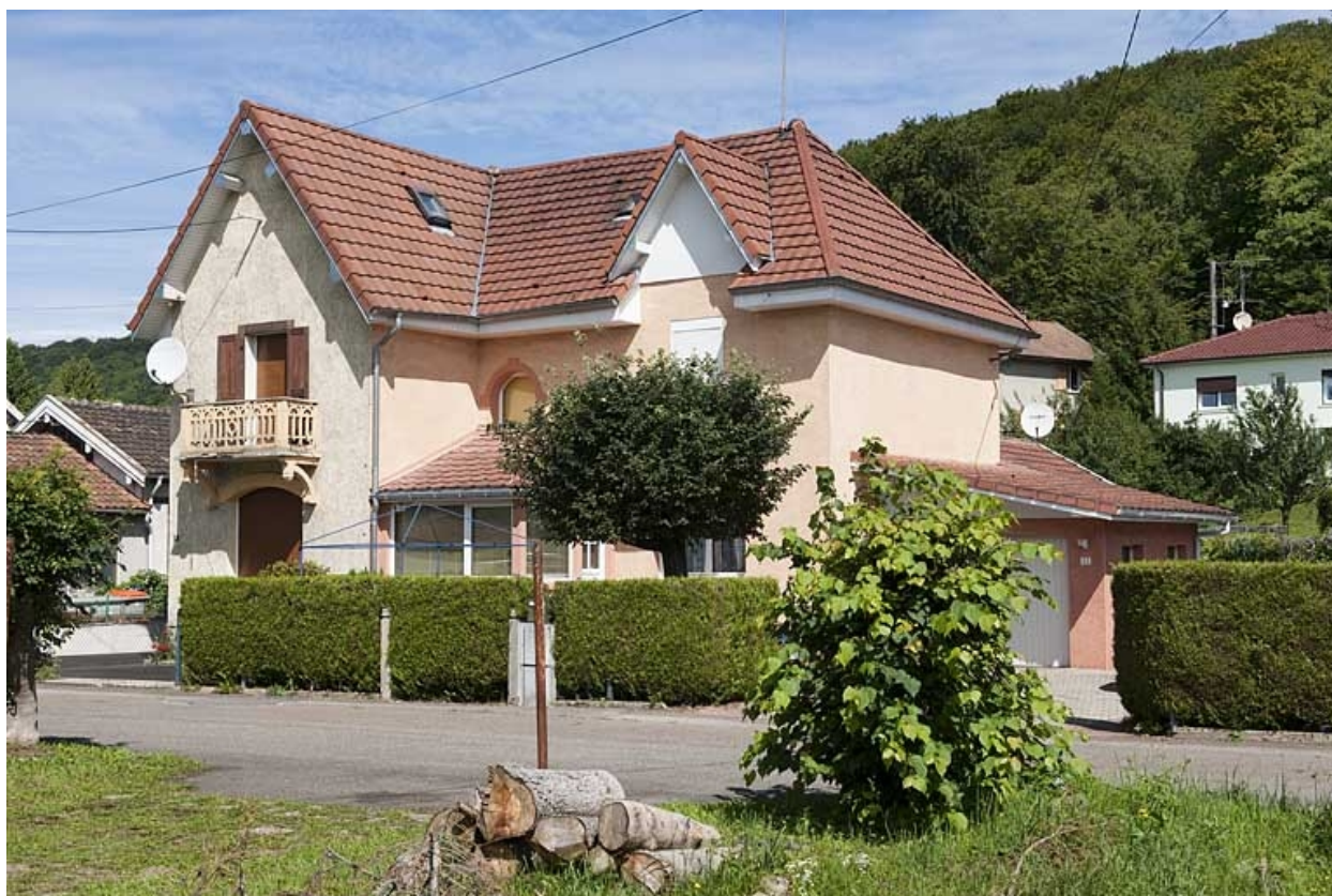
Maison de contremaîtres (n°12-14).
