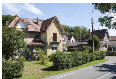
Maisons à deux logements de contremaître. Phot. Jérôme Mongreville IVR43_20112502149NUC4A
