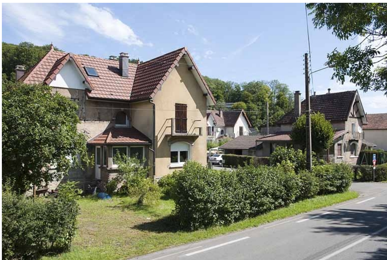
Maisons à deux logements de contremaître.
