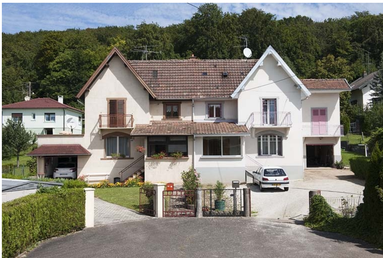
Maison de contremaîtres (n°8-10).
