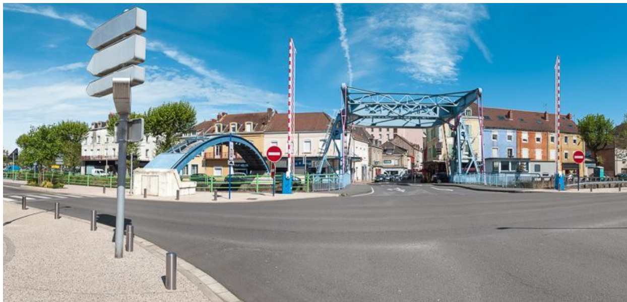
Vue d'ensemble du pont.
