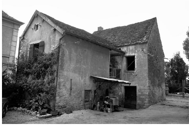
Vue d'ensemble. Phot. Bernard Lardière IVR43_19797000280Z
