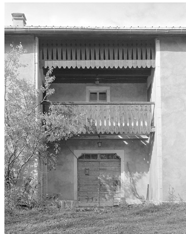
Galerie centrale sur la façade antérieure. Phot. Jérôme Mongreville IVR43_19963901523X
