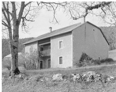
Façade antérieure et face nord-est. Phot. Jérôme Mongreville IVR43_19963901521X
