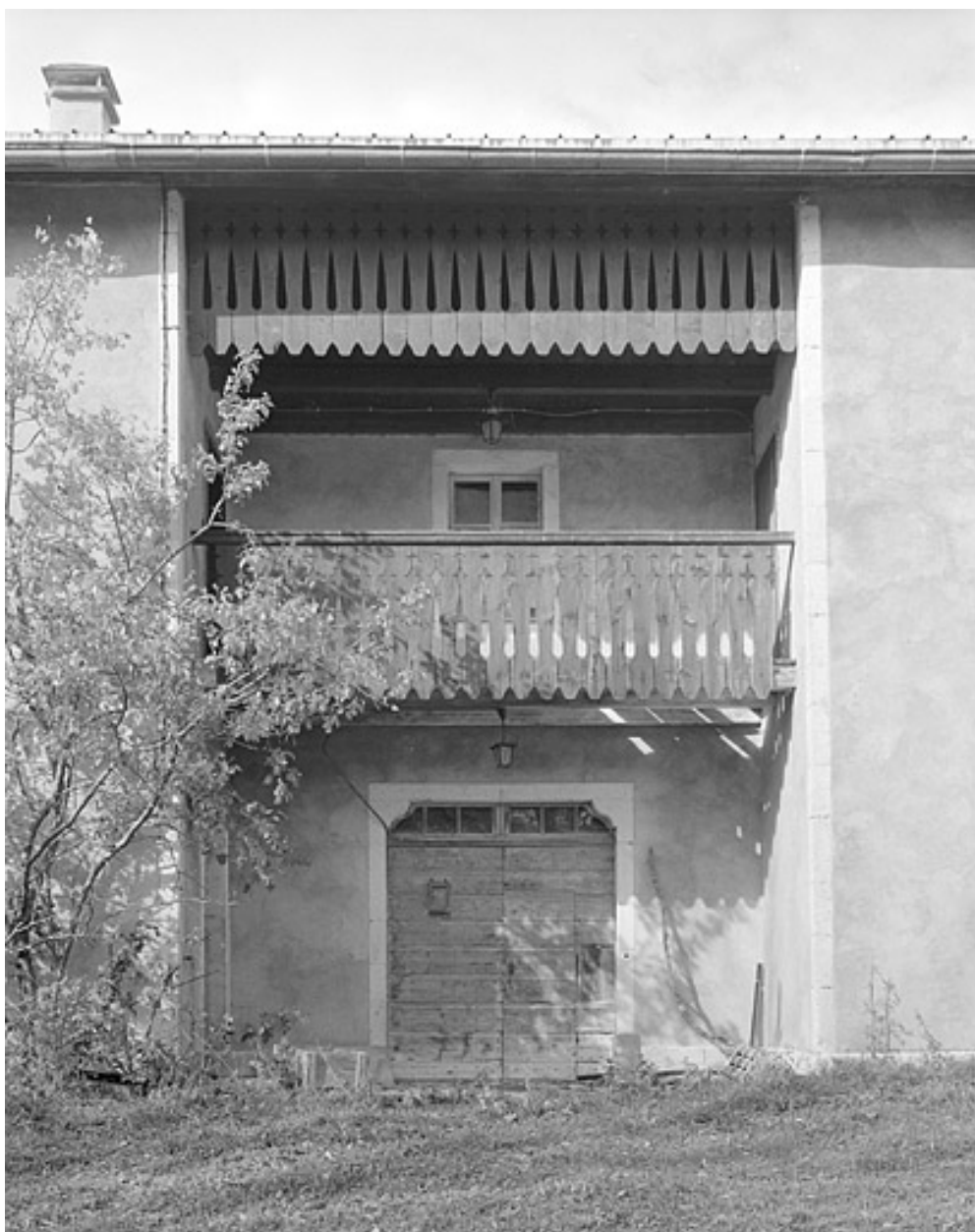
Galerie centrale sur la façade antérieure.
