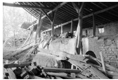
Atelier de fabrication : le four. Phot. Laurent Poupard IVR43_19883900712Z
