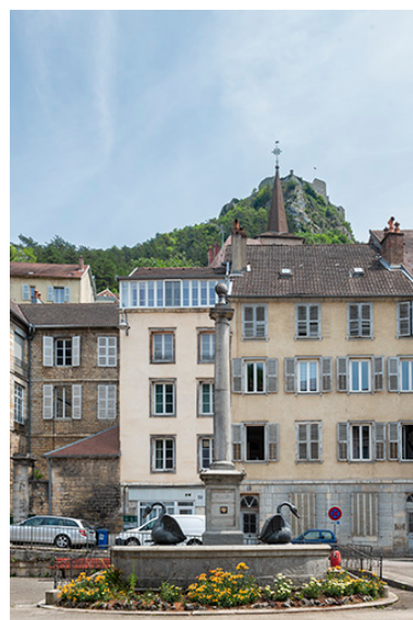
Vue depuis l'ouest. Phot. Jérôme Mongreville IVR43_20233900657NUC4A
