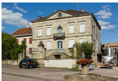
Vue générale. Phot. Sonia Dourlot IVR43_20167000144NUC2A
