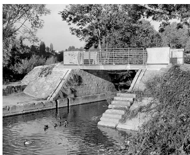
Passerelle de halage, depuis l'aval. Phot. Jérôme Mongreville IVR43_20032500104X
