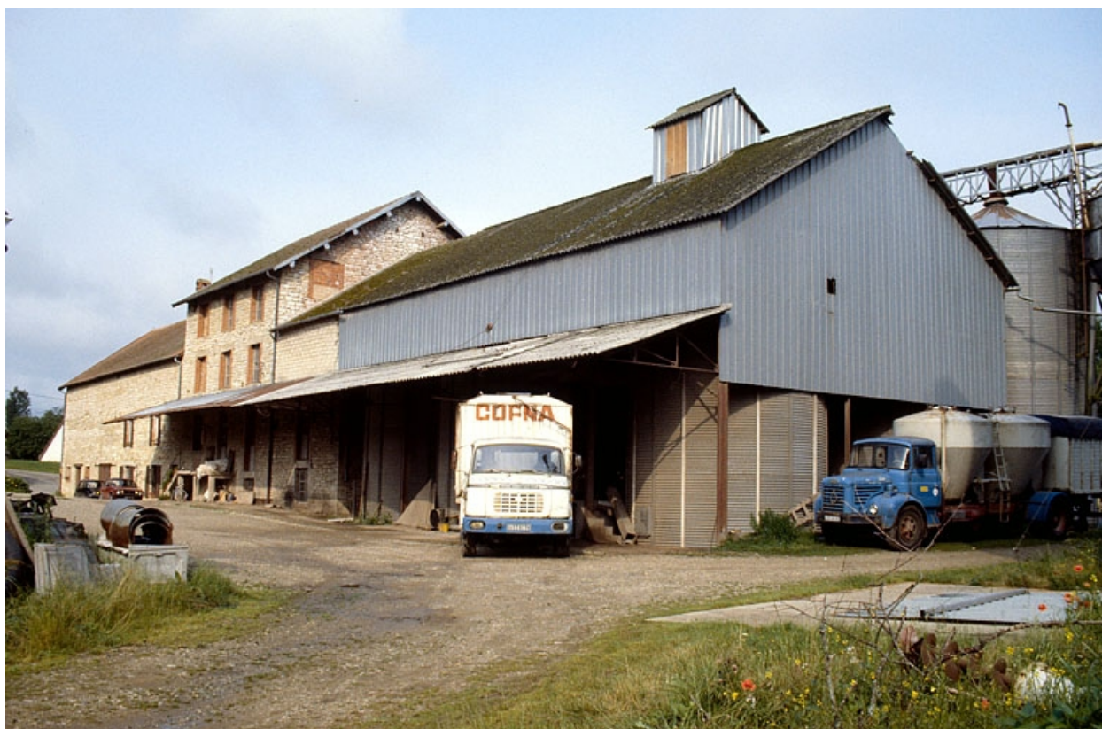
Hangar (E) et minoterie, depuis l'est.
