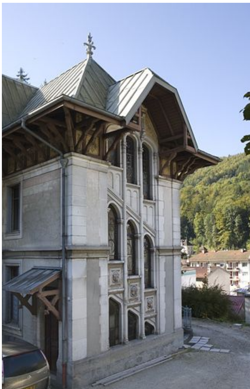
Elévation latérale gauche, de trois quarts gauche.
