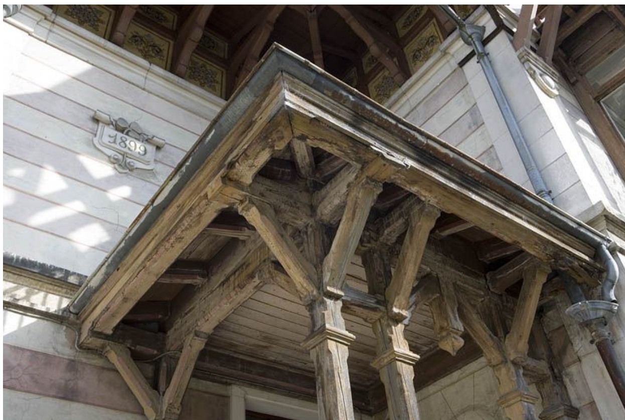
Elévation antérieure : charpente du porche.
