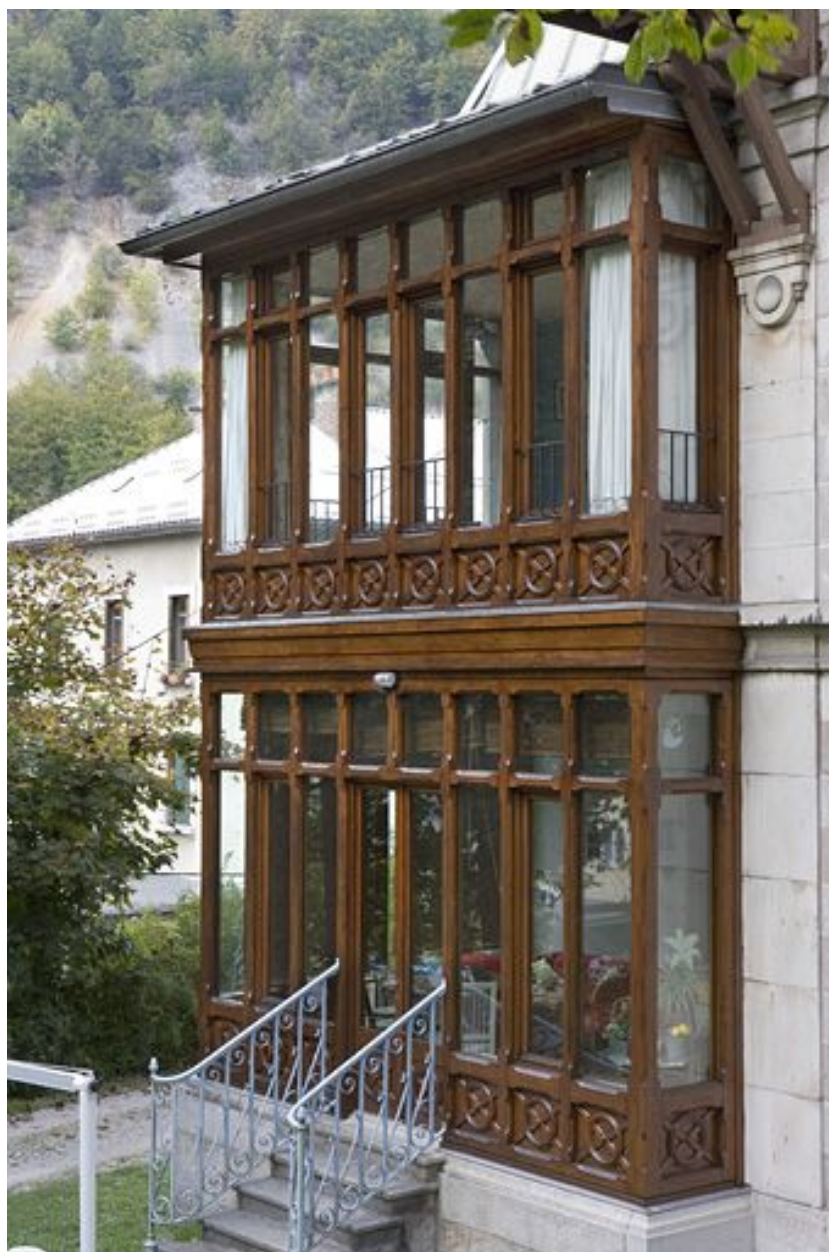
Elévation latérale droite : l'oriel.
