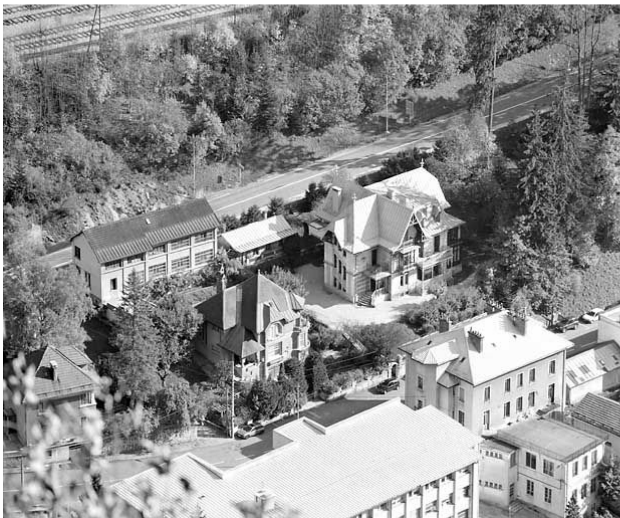
Vue d'ensemble plongeante, depuis l'ouest.
