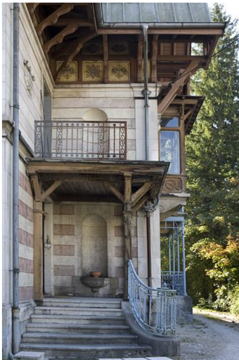
Elévation antérieure : le porche.
