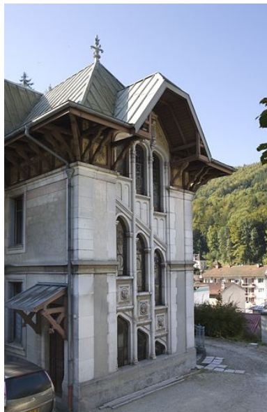
Elévation latérale gauche, de trois quarts gauche.
