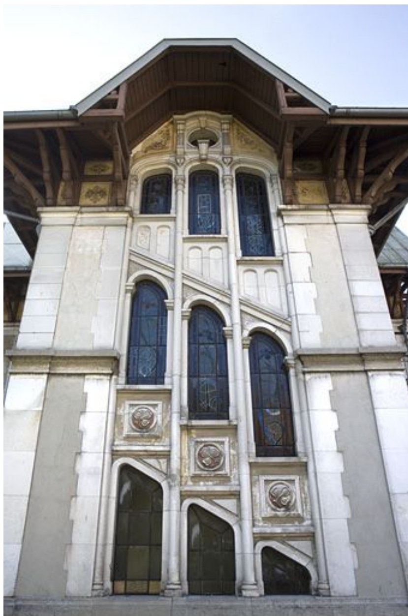
Elévation latérale gauche, en contre-plongée.
