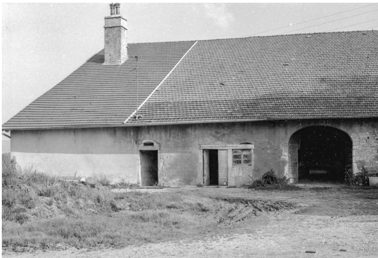
Gouttereau sur rue.
