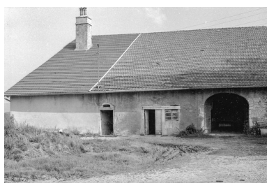
Gouttereau sur rue. Phot. Gilbert Poinot IVR43_19752501286Z
