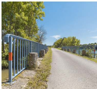
Traces du halage. Phot. Thierry Kuntz IVR26_20162101348NUC4A
