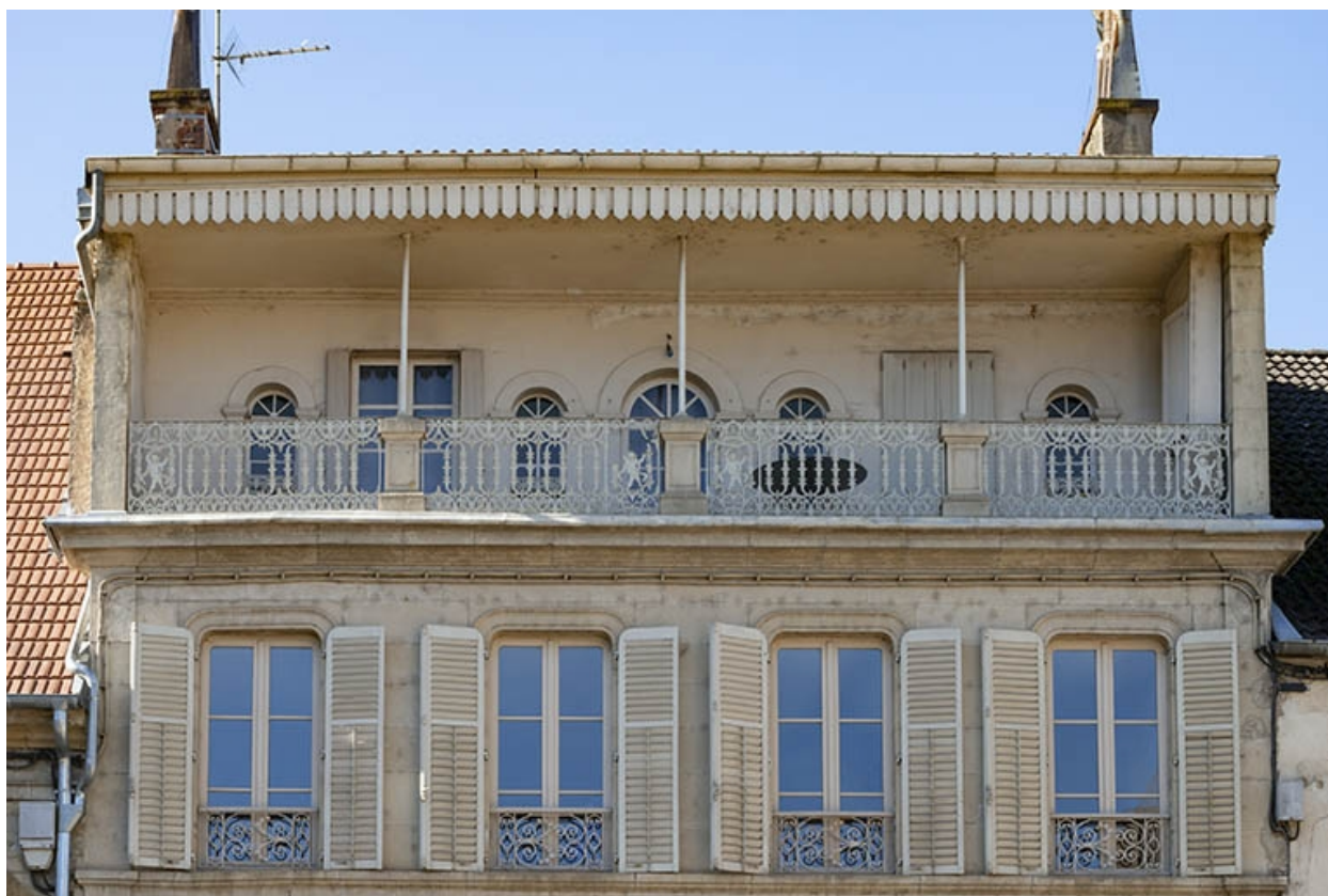
Détail des deux derniers niveaux.
