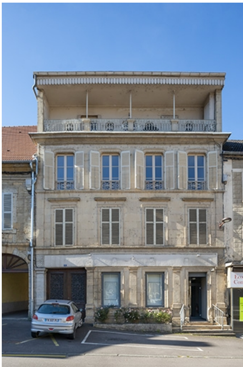
Façade de l'immeuble sur la rue.
