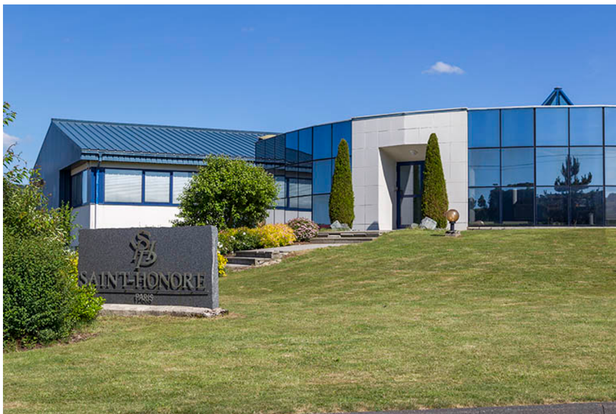
Entrée du bureau (au nord).
