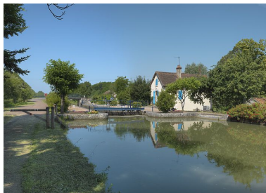
Vue d'ensemble du site. Phot. Thierry Kuntz IVR26_20135800326NUC4A
