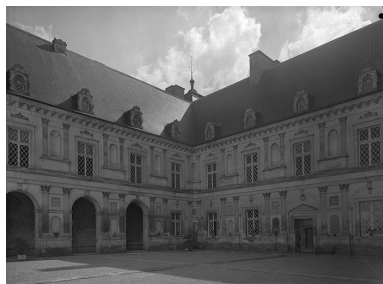
Façades sur cour (nord et est). Phot. Jean-Luc Duthu IVR26_19748901367V
