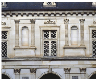
Façade sur cour, détail Phot. Jean-Luc Duthu IVR26_19918900018XA
