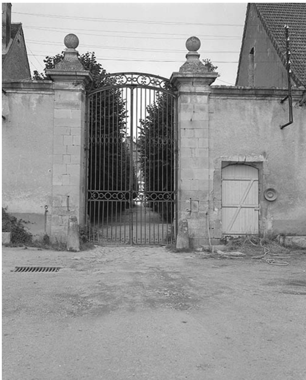
Grille d'entrée de la cour des communs.
