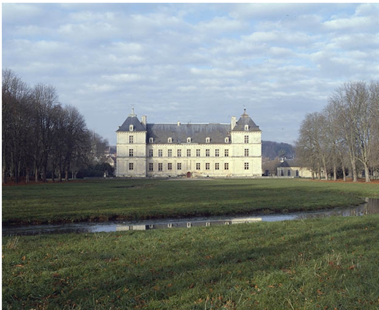
Vue d'ensemble de l'élévation sud.
