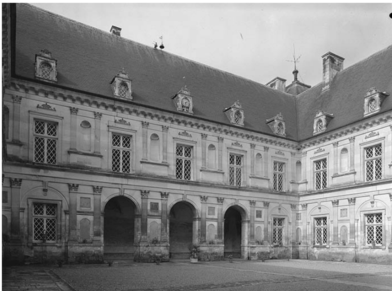
Façades sur cour (sud et ouest).
