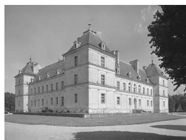
Façades sud et ouest. Phot. Jean-Luc Duthu IVR26_19748901364V
