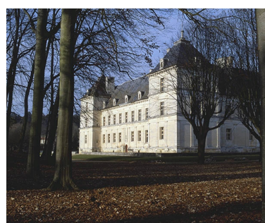
Elévation sud, vue de trois-quarts. Phot. Jean-Luc Duthu IVR26_19918900012XA
