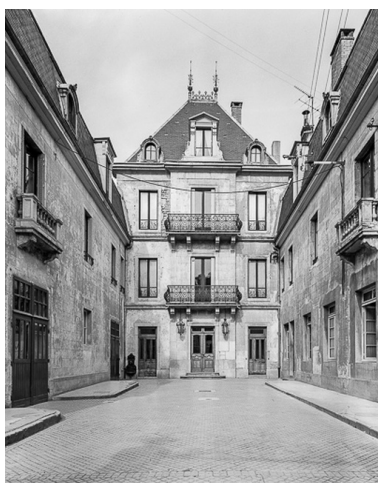
Logement patronal. Façade antérieure sur cour (1977). Phot. Yves Sancey IVR43_19772500056V
