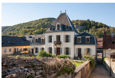
Logement patronal. Façade postérieure. Phot. Jérôme Mongreville IVR43_20152501731NUC4A
