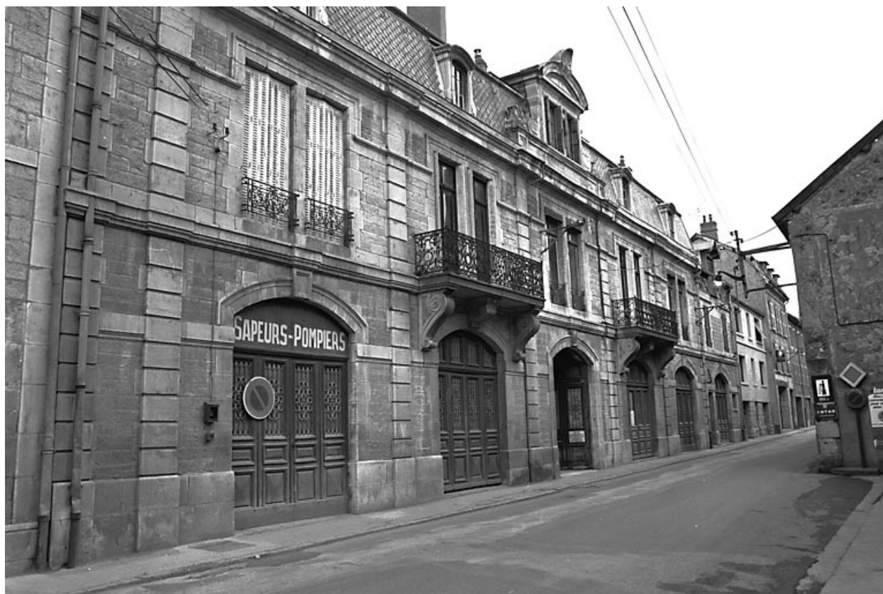
Façade antérieure de l'atelier sur rue (1977).
