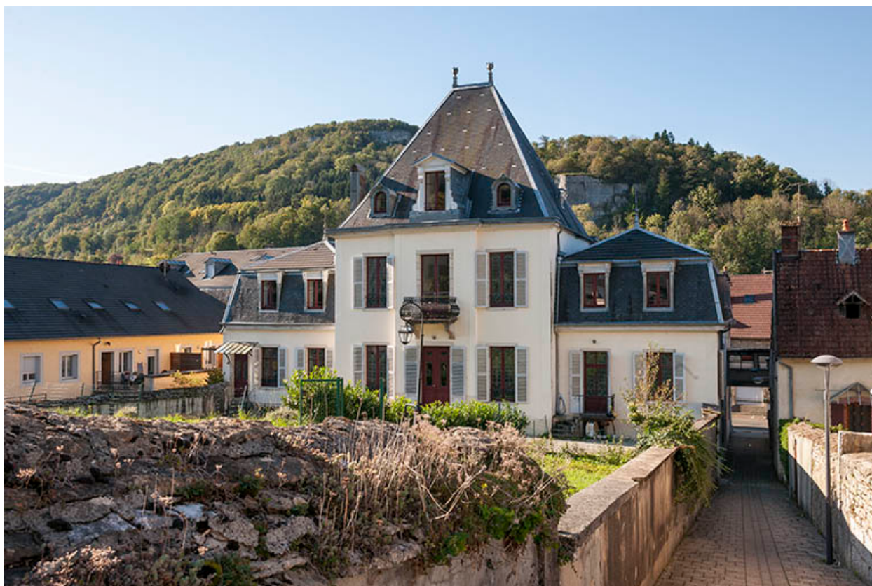
Logement patronal. Façade postérieure.
