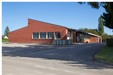
Pignon ouest et façade sud antérieure de l'atelier. Phot. Sonia Dourlot IVR43_20143900862NUC2A
