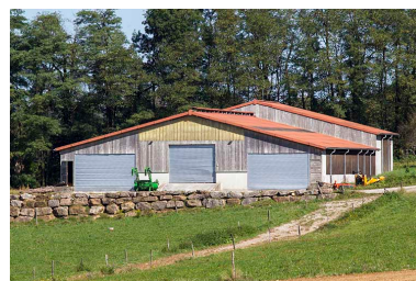
Angle sud-est, pignon sud de l'étable ouest. Phot. Sonia Dourlot IVR43_20143900898NUC2A
