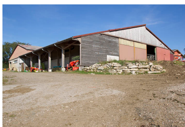
Angle sud-ouest de la ferme et des deux étables. Phot. Sonia Dourlot IVR43_20143900890NUC2A
