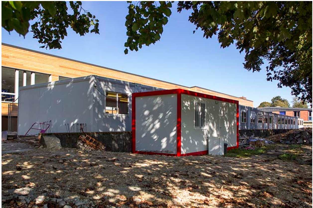
Depuis l'angle sud-est, vue sur les anciens préfabriqués et la nouvelle construction de 2014. (salle de cours)
