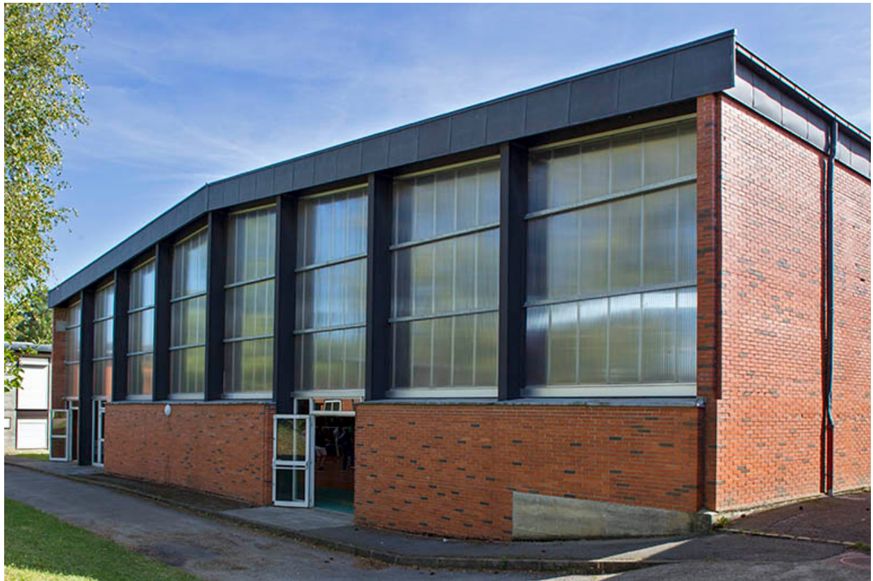
Façade nord du gymnase.
