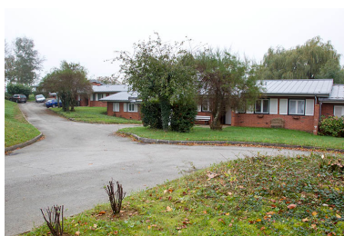
Logements : vue d'ensemble. Phot. Sonia Dourlot IVR43_20143900910NUC2A
