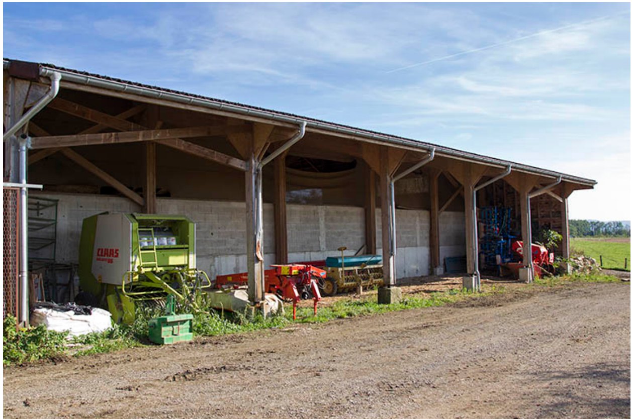
Détail de la façade ouest de la ferme et des deux étables.
