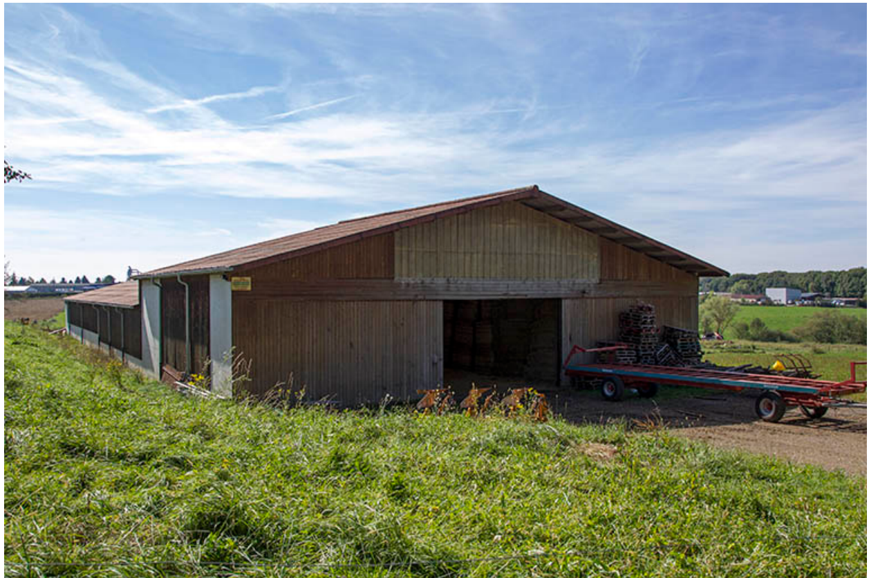
Pignon nord de l'étable ouest.
