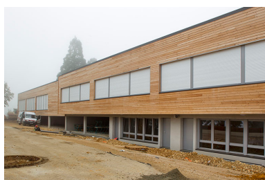
Façade postérieure - est - de la nouvelle construction de 2014. (salle de cours) Phot. Sonia Dourlot IVR43_20143900859NUC2A
