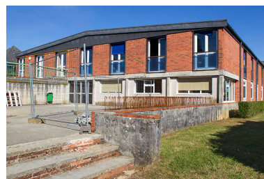
Pignon sud du foyer, bâtiment postérieur de l'externat du lycée. Phot. Sonia Dourlot IVR43_20143900836NUC2A
