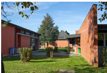
Depuis le sud, face au pignon sud du pavillon d'entrée, entre la façade antérieure ouest de l'aile sud du lycée et le centre de formation des apprentis. Phot. Sonia Dourlot IVR43_20143900798NUC2A
