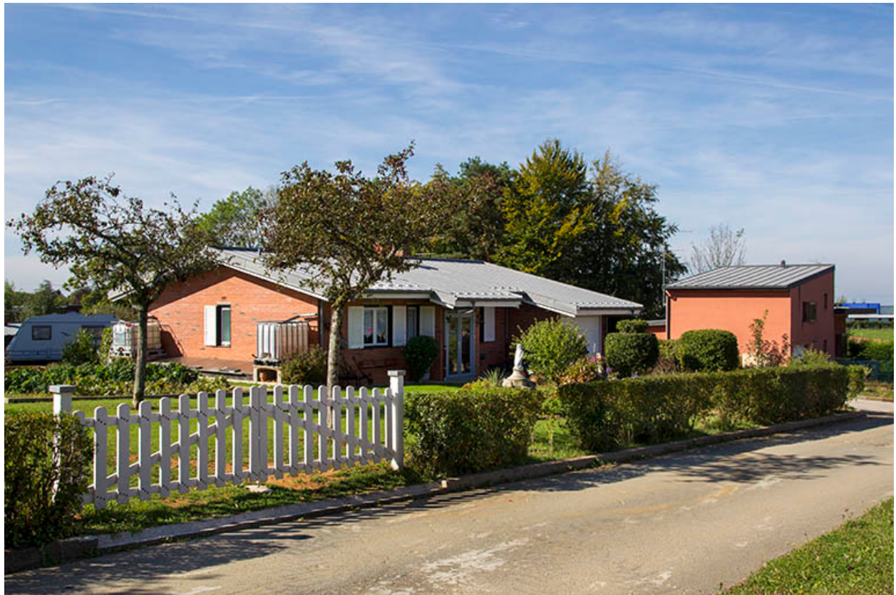
Logements au sud, face à la formation professionnelle.
