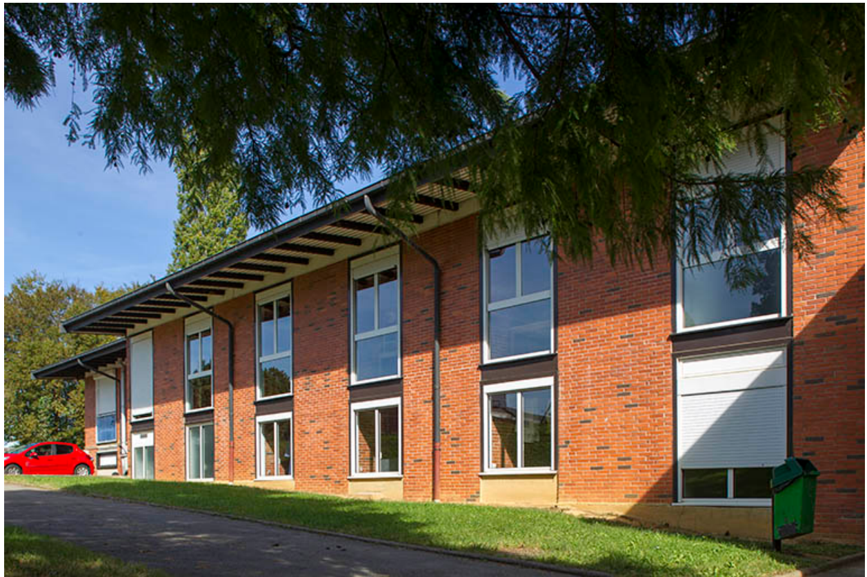
Détail de la façade postérieure est de l'internat.
