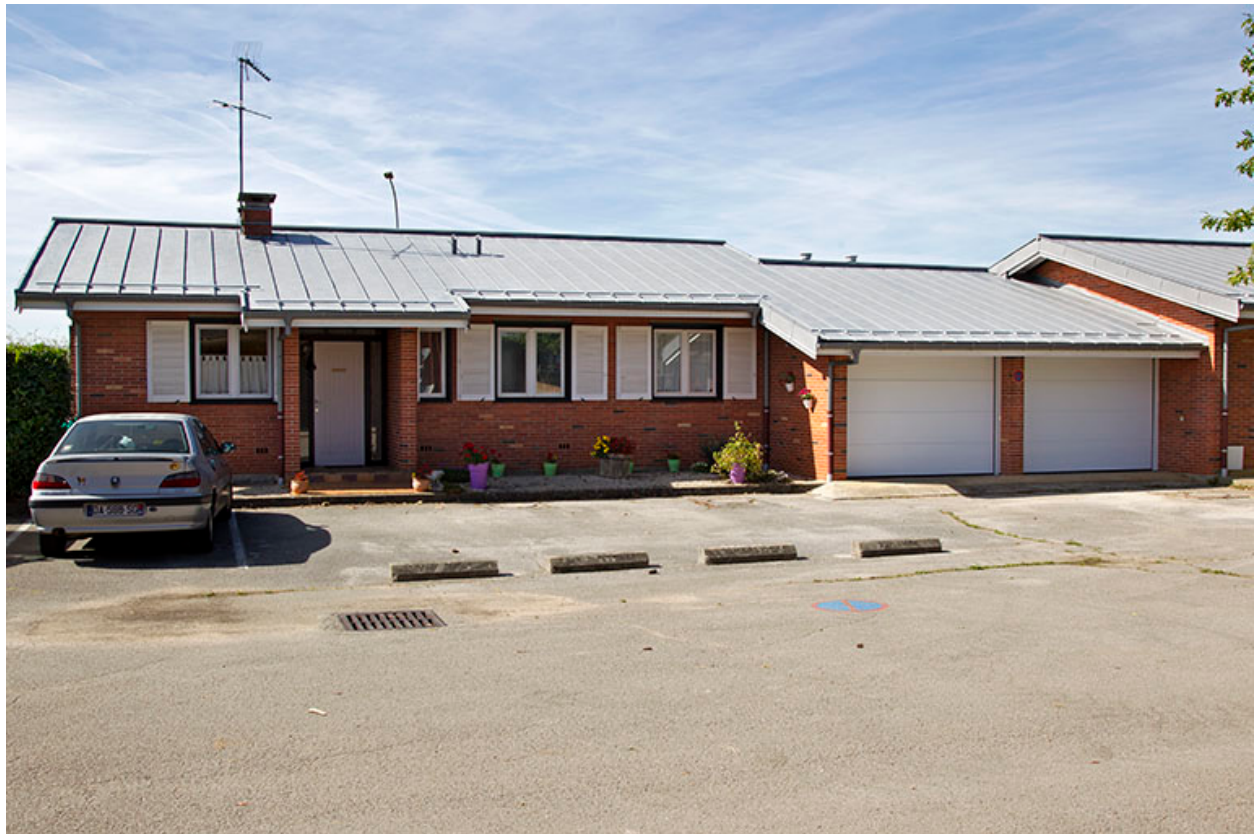
Logements : détail de la façade sur rue de la barre sud.
