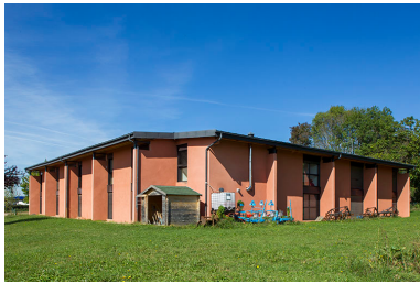
Angle sud-est du bâtiment d'hébergement adultes. Phot. Sonia Dourlot IVR43_20143900920NUC2A
