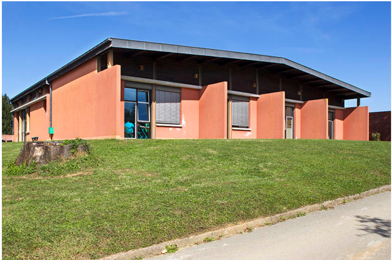
Angle sud-ouest du centre de formation des apprentis.
