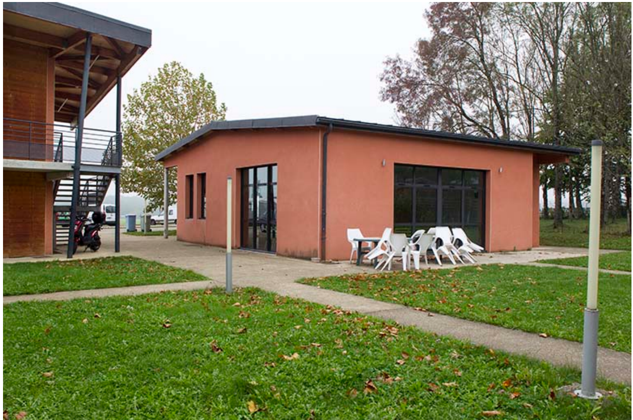
Angle sud-est et pignon sud du foyer des stagiaires.
