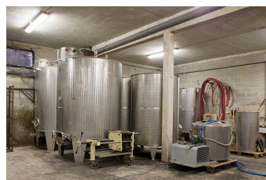
Cuves dans le cuvage. Phot. Sonia Dourlot IVR43_20143900885NUC2A
