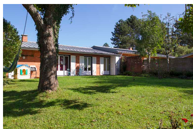
Logements : face postérieure- sud- dans la barre au sud. Phot. Sonia Dourlot IVR43_20143900904NUC2A
