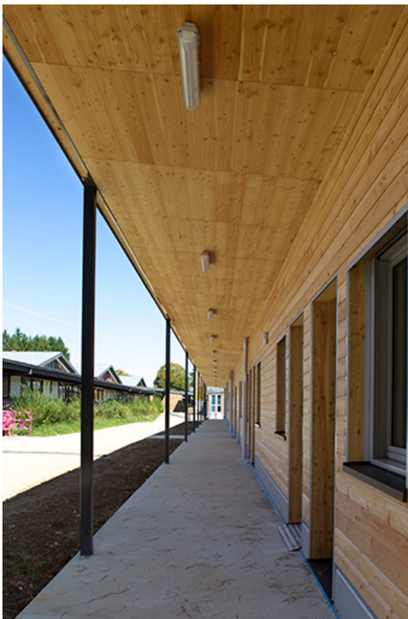
Façade antérieure - ouest - de la nouvelle construction de 2014. (salle de cours)
