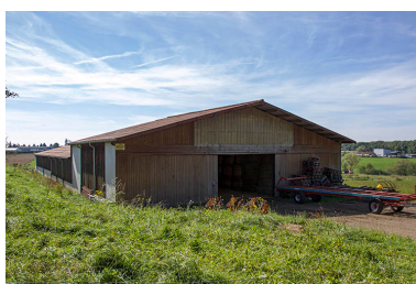
Pignon nord de l'étable ouest. Phot. Sonia Dourlot IVR43_20143900900NUC2A
