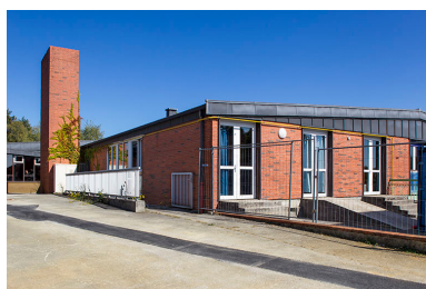
Angle sud-ouest du foyer, bâtiment postérieur de l'externat du lycée. Phot. Sonia Dourlot IVR43_20143900837NUC2A
