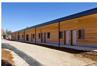
Façade antérieure - ouest - de la nouvelle construction de 2014. (salle de cours) Phot. Sonia Dourlot IVR43_20143900857NUC2A
