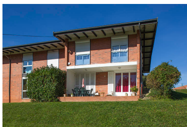
Angle nord-est, façade postérieure est de l'internat abritant des logements de fonction. Phot. Sonia Dourlot IVR43_20143900847NUC2A
