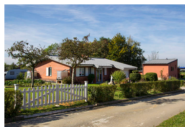
Logements au sud, face à la formation professionnelle. Phot. Sonia Dourlot IVR43_20143900903NUC2A
