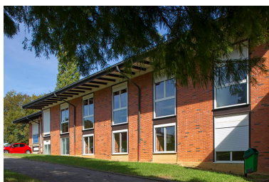
Détail de la façade postérieure est de l'internat. Phot. Sonia Dourlot IVR43_20143900852NUC2A
