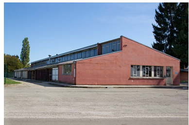
Pignon ouest et façade nord postérieure de l'atelier. Phot. Sonia Dourlot IVR43_20143900861NUC2A
