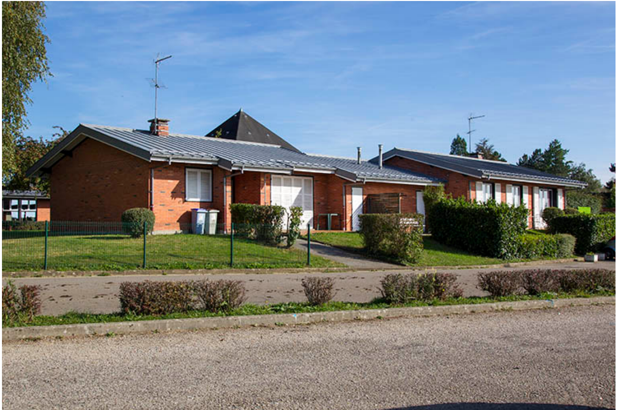
Logements : vue postérieure sur rue des deux logements nord.
