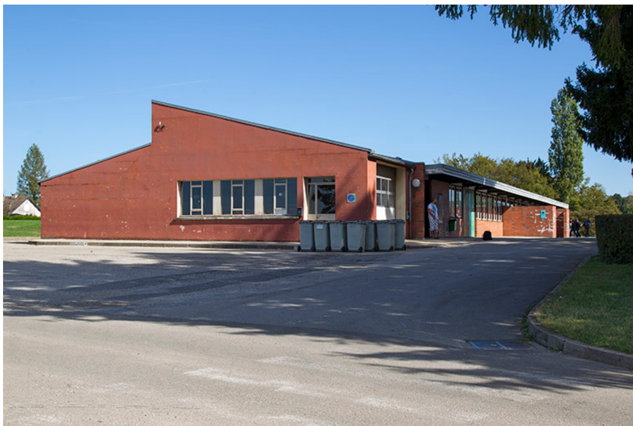
Pignon ouest et façade sud antérieure de l'atelier.
