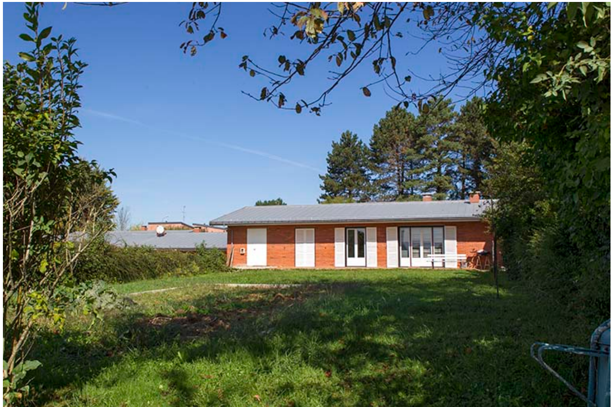
Logements : vue postérieure sur le jardinet.
