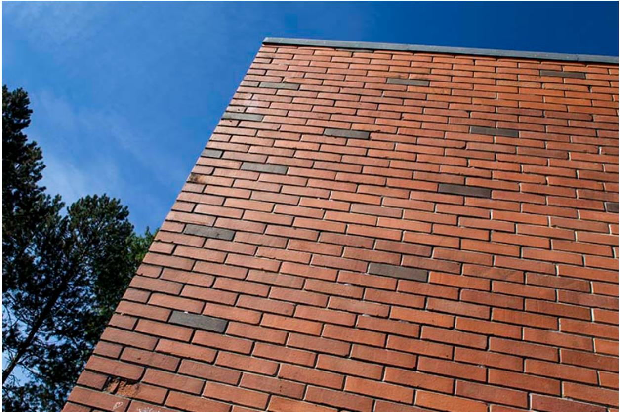
Détail de mur du gymnase.
