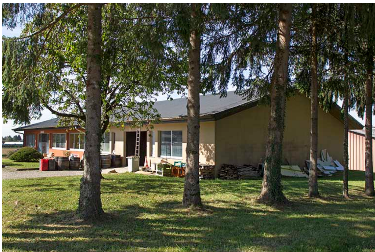
Pignon nord et façade antérieure est du magasin de commerce de l'exploitation.
