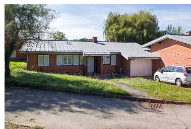
Logements : face antérieure- nord-de la barre au sud. Phot. Sonia Dourlot IVR43_20143900906NUC2A
