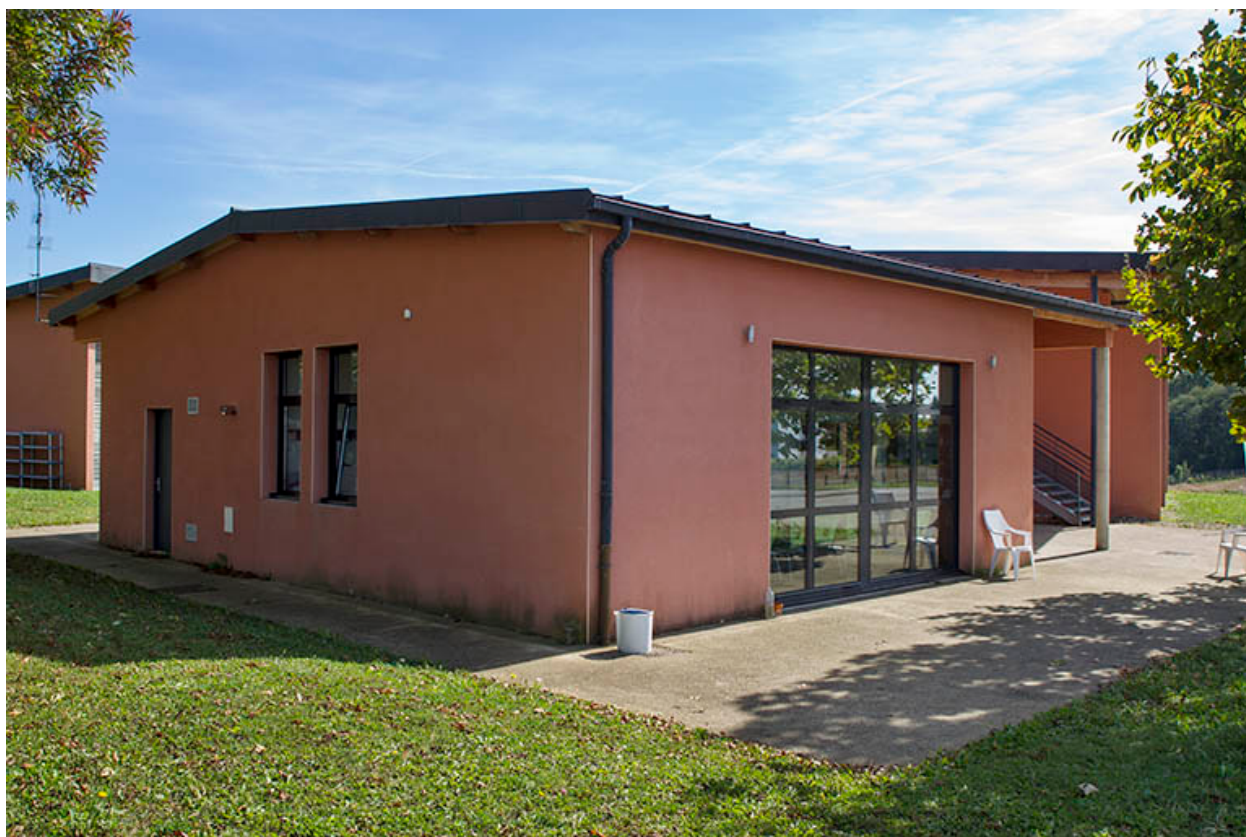
Angle nord-ouest du foyer des stagiaires.
