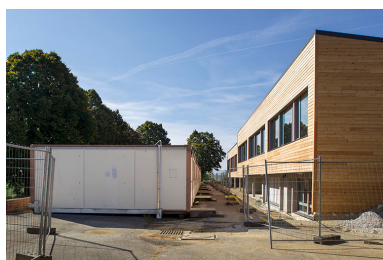
Depuis le pignon nord, vue sur les anciens préfabriqués et la nouvelle construction de 2014. (salle de cours) Phot. Sonia Dourlot IVR43_20143900855NUC2A
