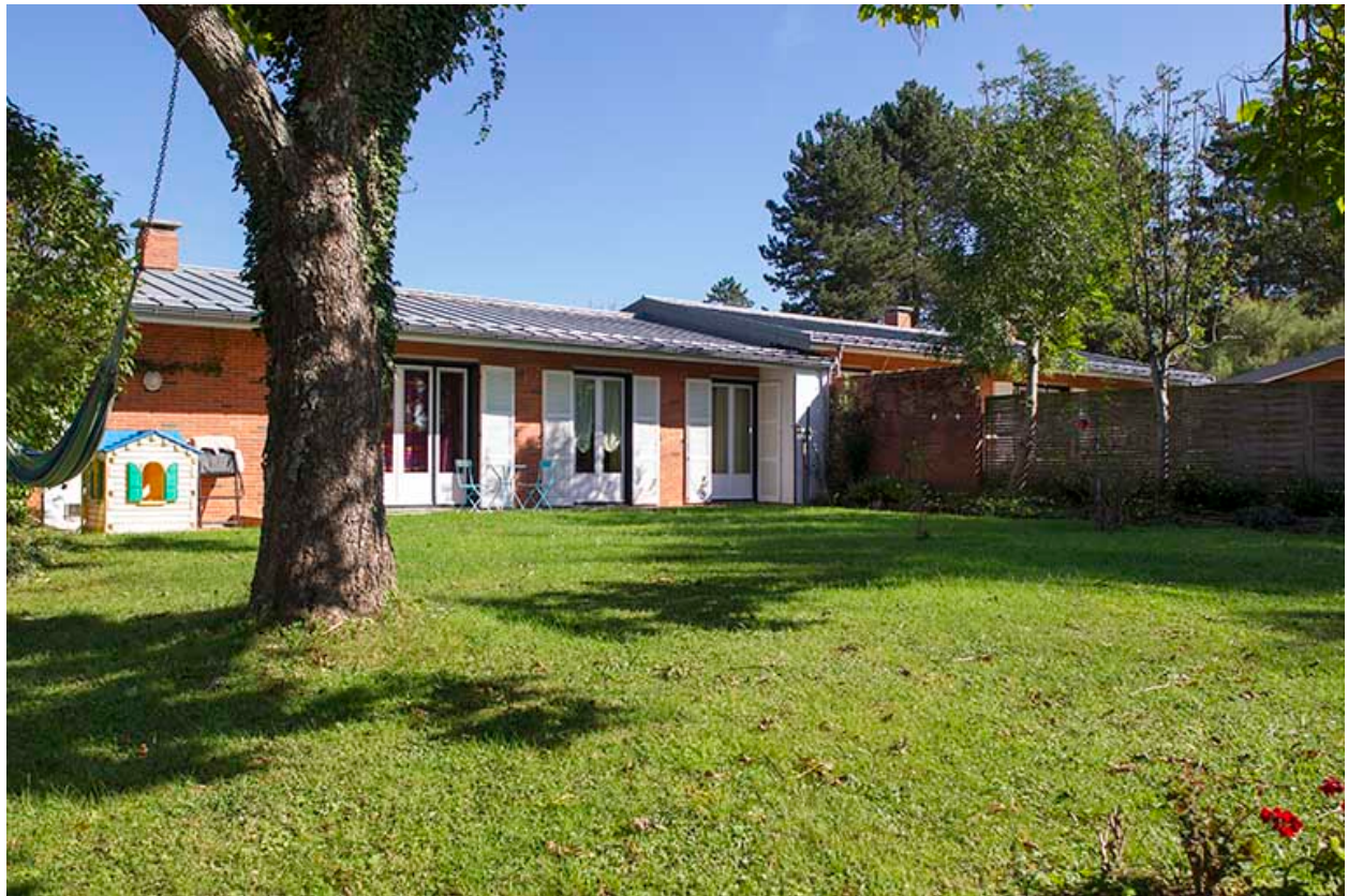
Logements : face postérieure-sud- dans la barre au sud.
