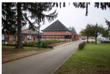
Vue sur la passerelle d'entrée, du nord-ouest de l'externat. Phot. Sonia Dourlot IVR43_20143900804NUC2A
