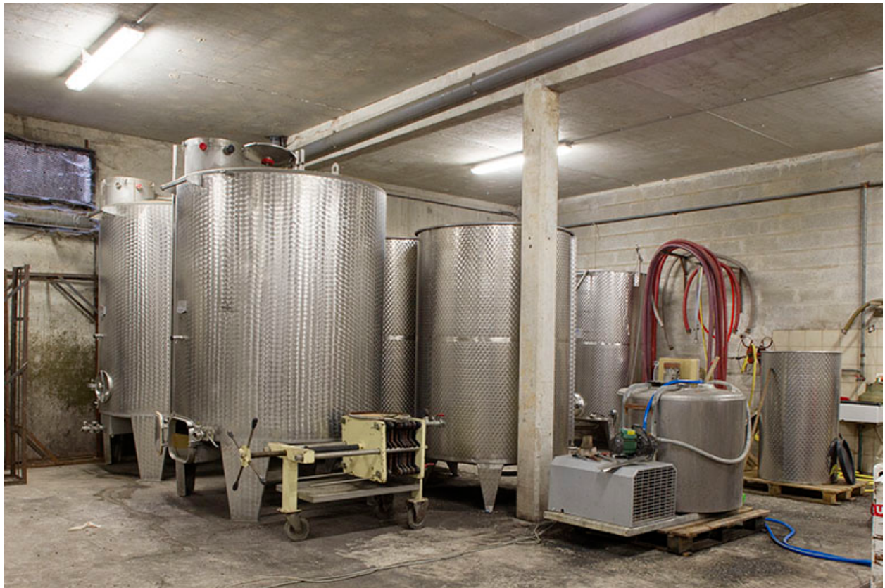
Cuves dans le cuvage.
