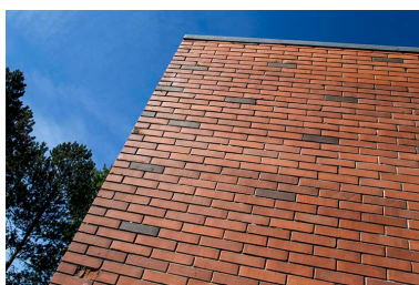
Détail de mur du gymnase. Phot. Sonia Dourlot IVR43_20143900816NUC2A
