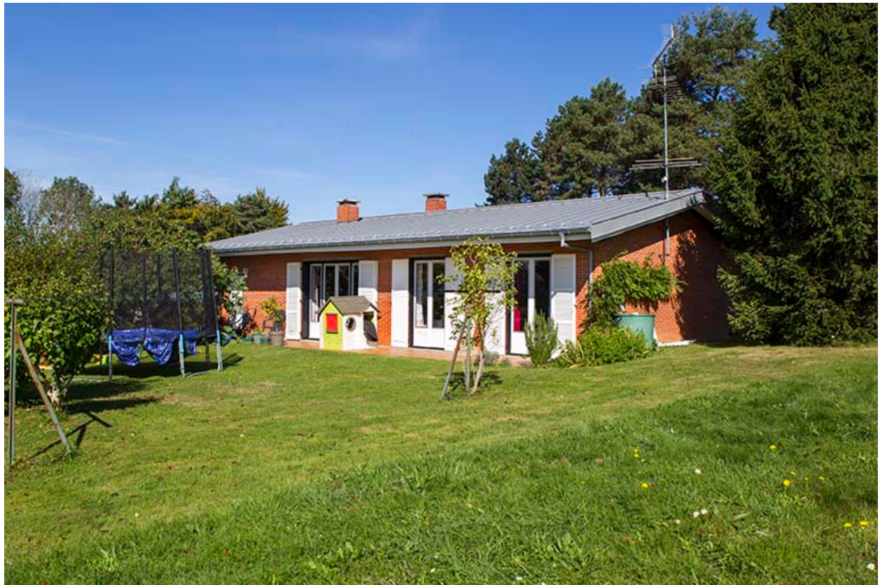
Logements : face postérieure-sud de la barre au sud, extrémité est.
