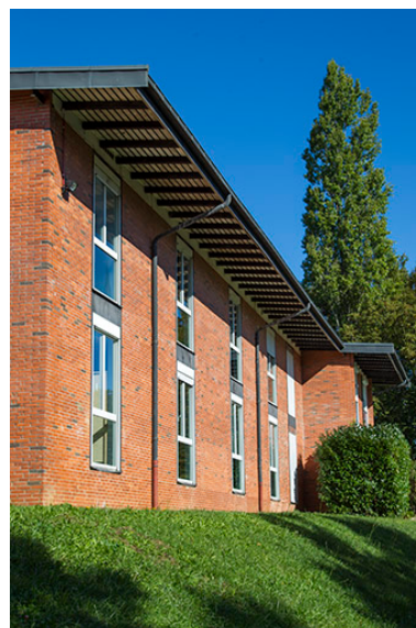
Façade postérieure est de l'internat. Phot. Sonia Dourlot IVR43_20143900849NUC2A
