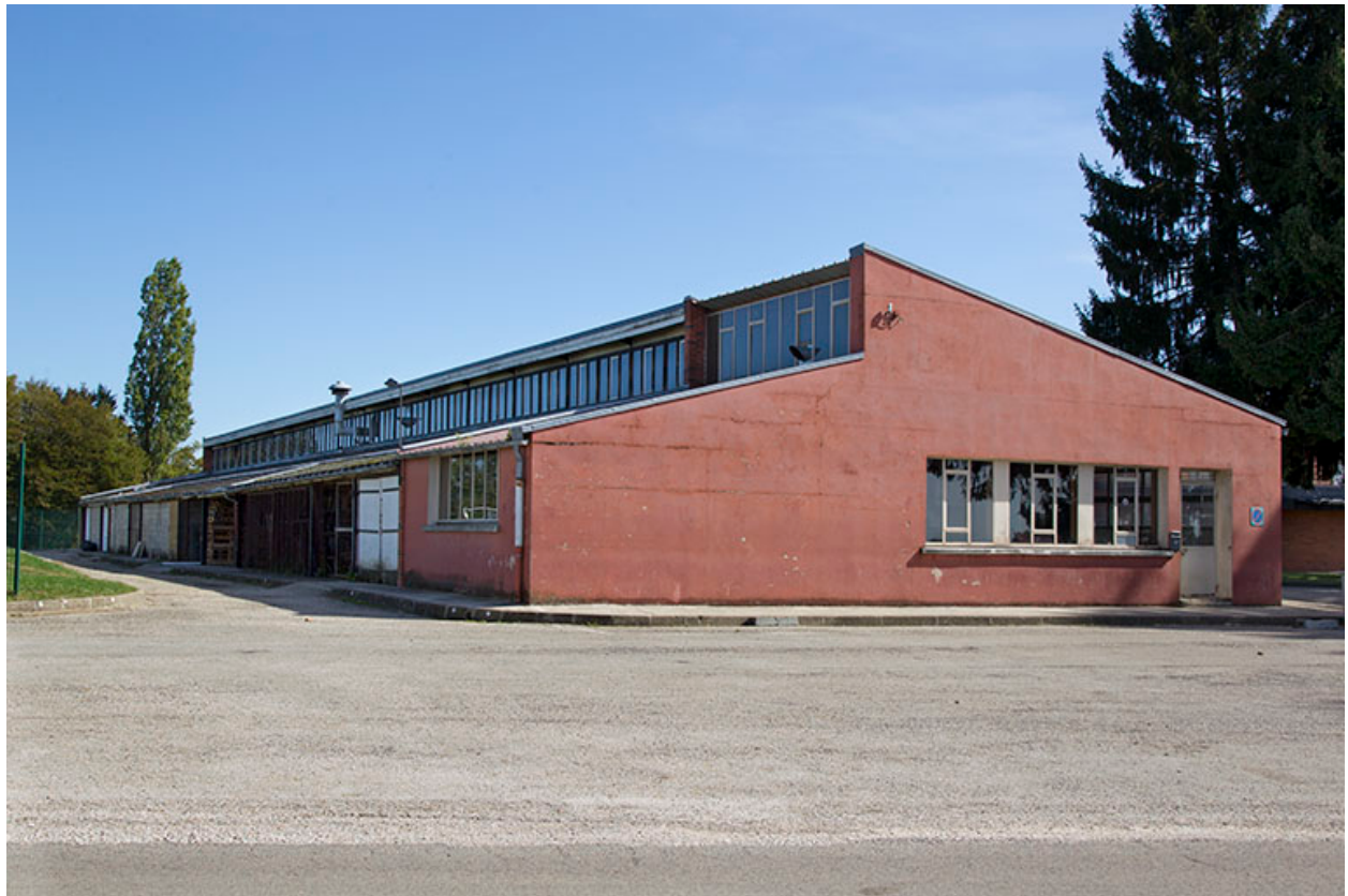
Pignon ouest et façade nord postérieure de l'atelier.
