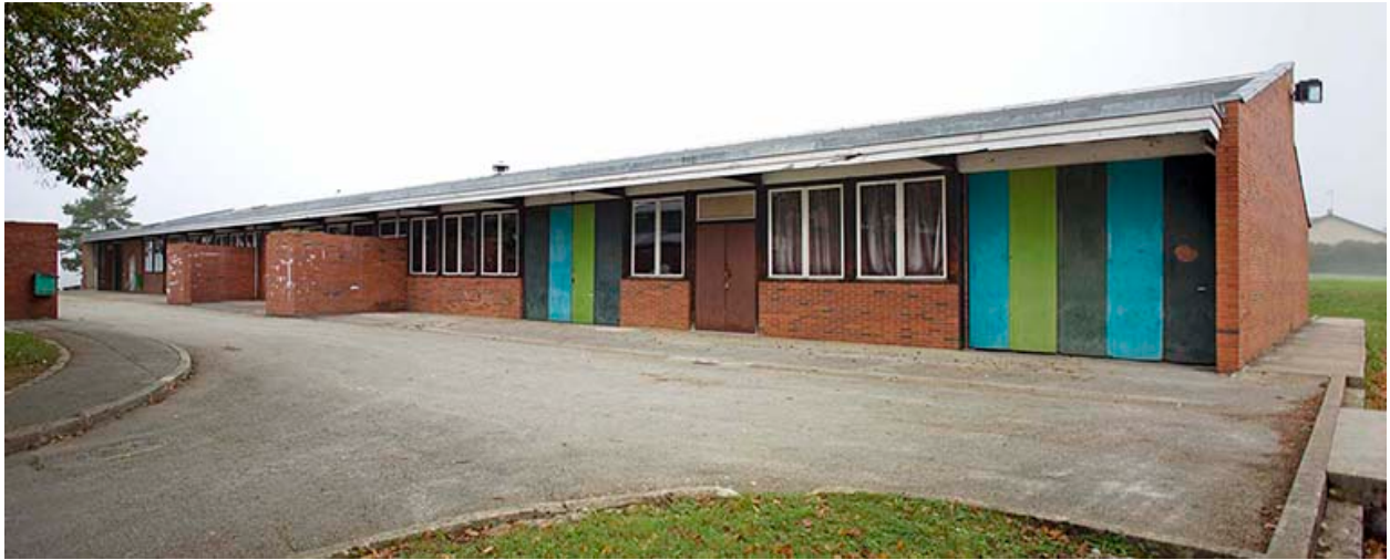
Angle sud-est et façade sud antérieure de l'atelier.
