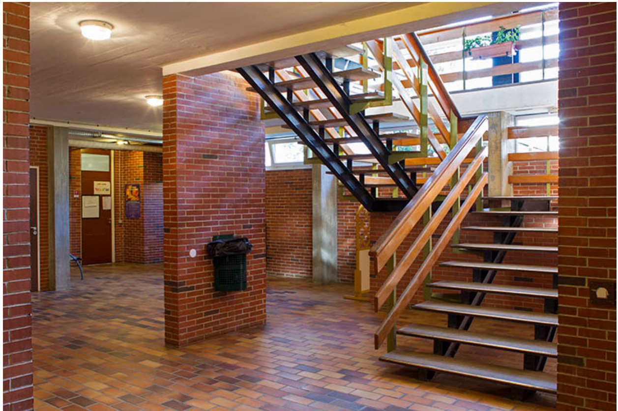
Détail de circulation intérieure.
