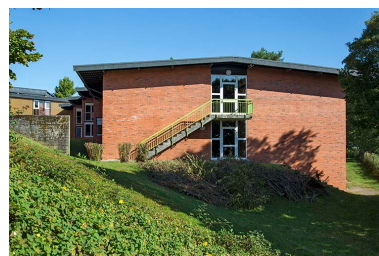
Pignon sud de l'internat. Phot. Sonia Dourlot IVR43_20143900850NUC2A
