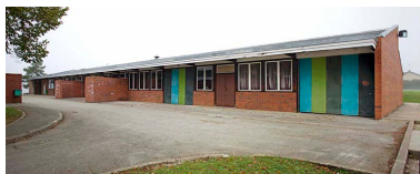
Angle sud-est et façade sud antérieure de l'atelier. Phot. Sonia Dourlot IVR43_20143900864NUC4AQ
