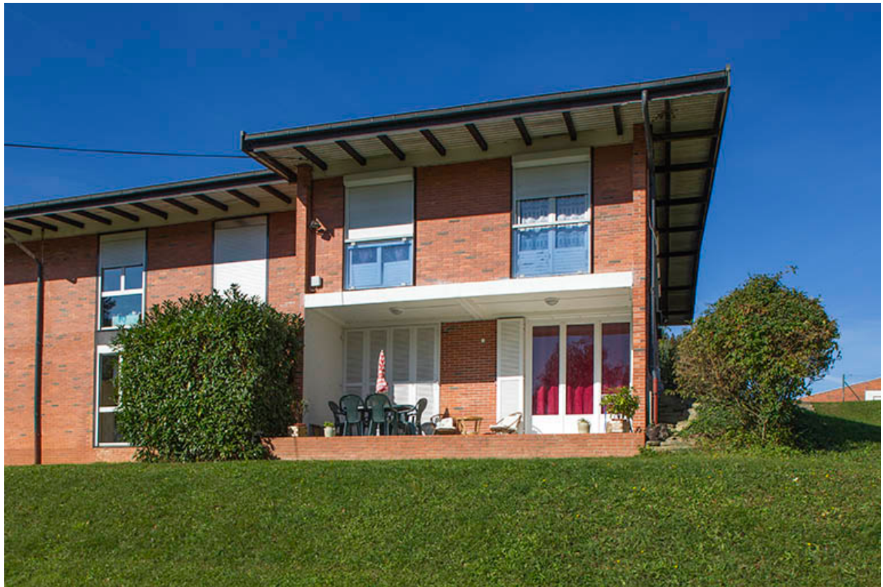
Angle nord-est, façade postérieure est de l'internat abritant des logements de fonction.
