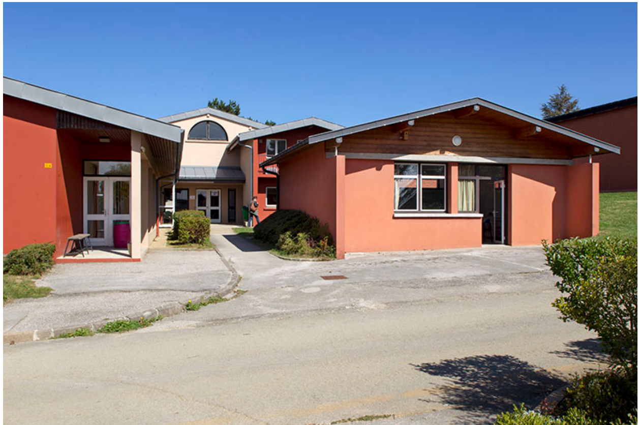
Façades antérieures sud du Centre de Formation Professionnelle et de Promotion Agricoles.
