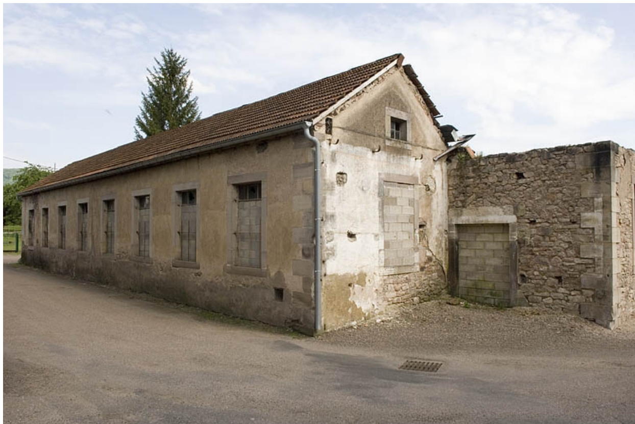
Façade nord de l'atelier de fabrication.
