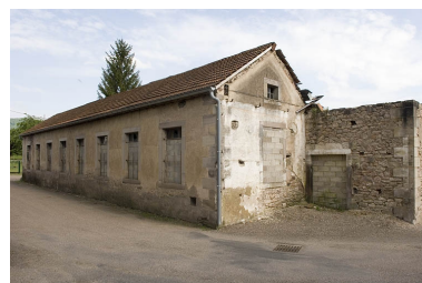
Façade nord de l'atelier de fabrication.
