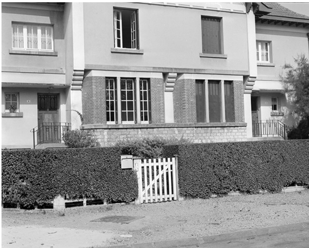
Détail du rez-de-chaussée de la façade antérieure.
