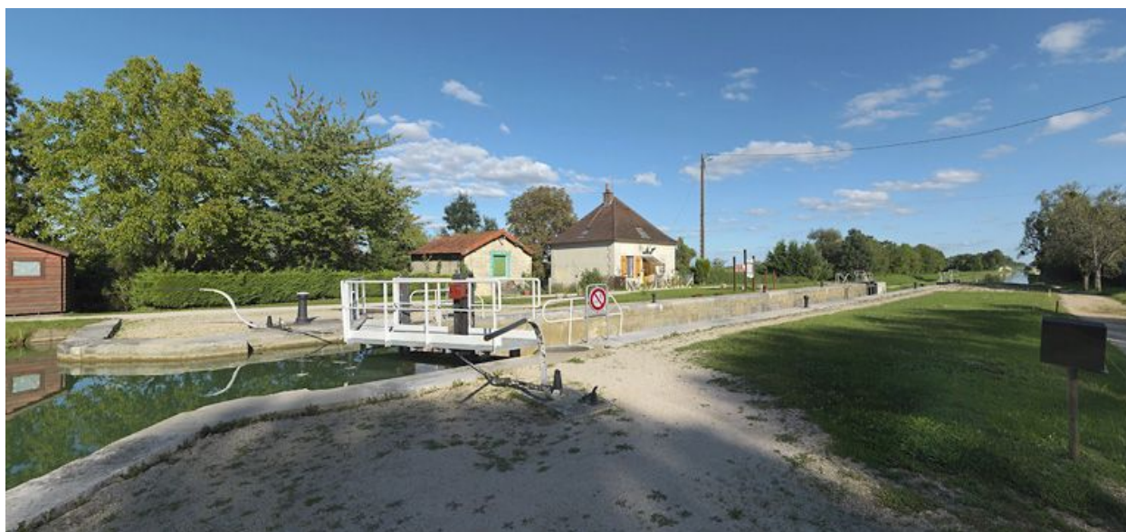
Vue d'ensemble, prise d'amont.
