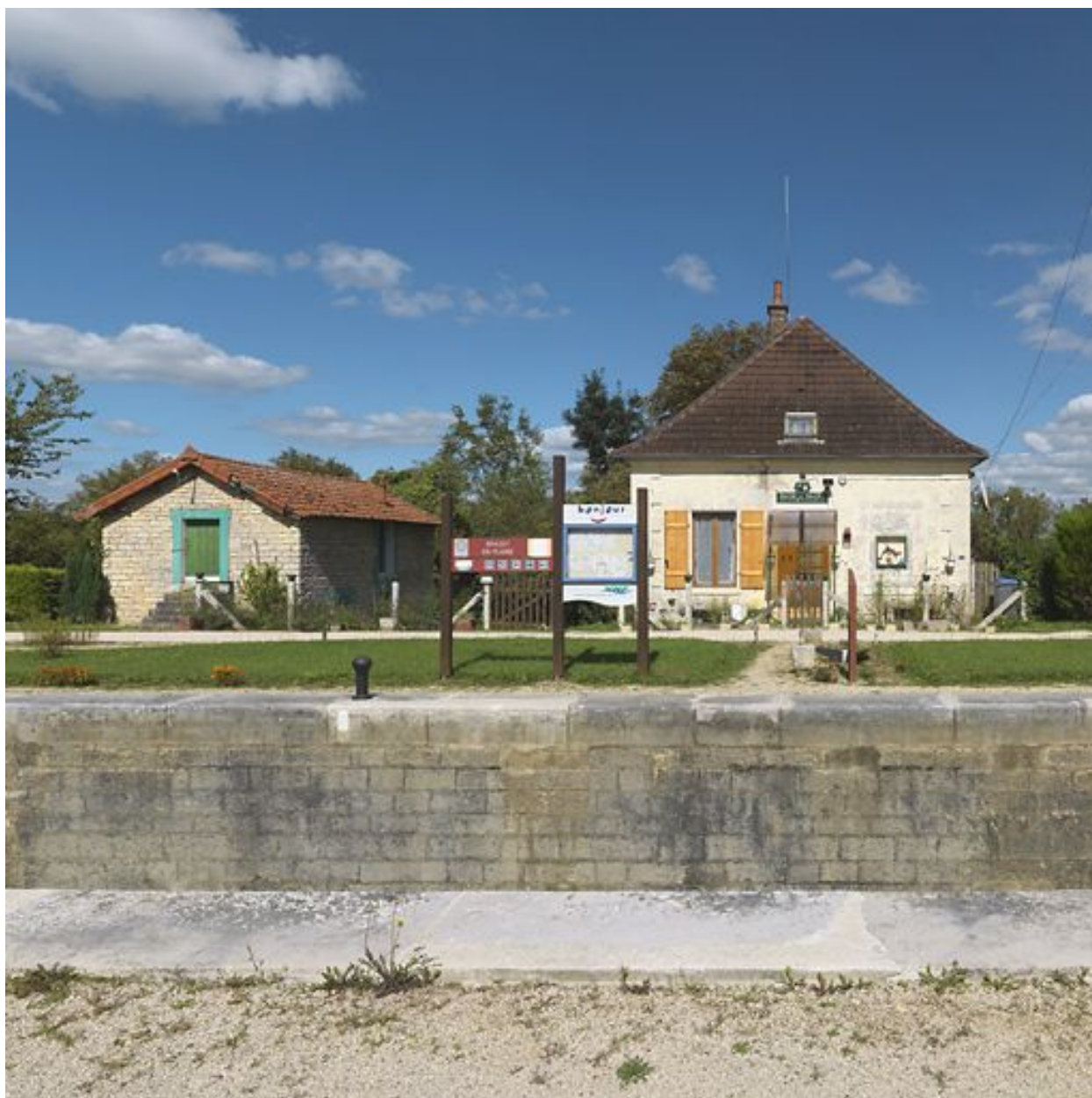
Vue de face de la maison éclésièr et de ses annexes.
