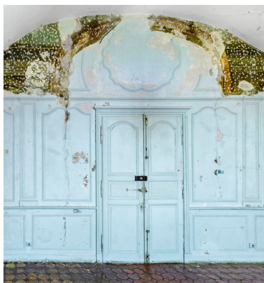
Peinture du petit salon : mur est. Phot. Thierry Kuntz IVR26_20192100034NUC4A
