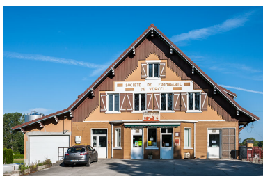
Façade antérieure. Phot. Jérôme Mongreville IVR43_20142501306NUC4A
