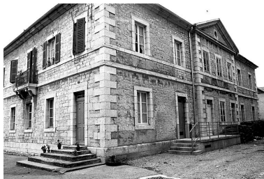
Vue de trois quarts gauche. Phot. Gilbert Poinot IVR43_19752500727Z
