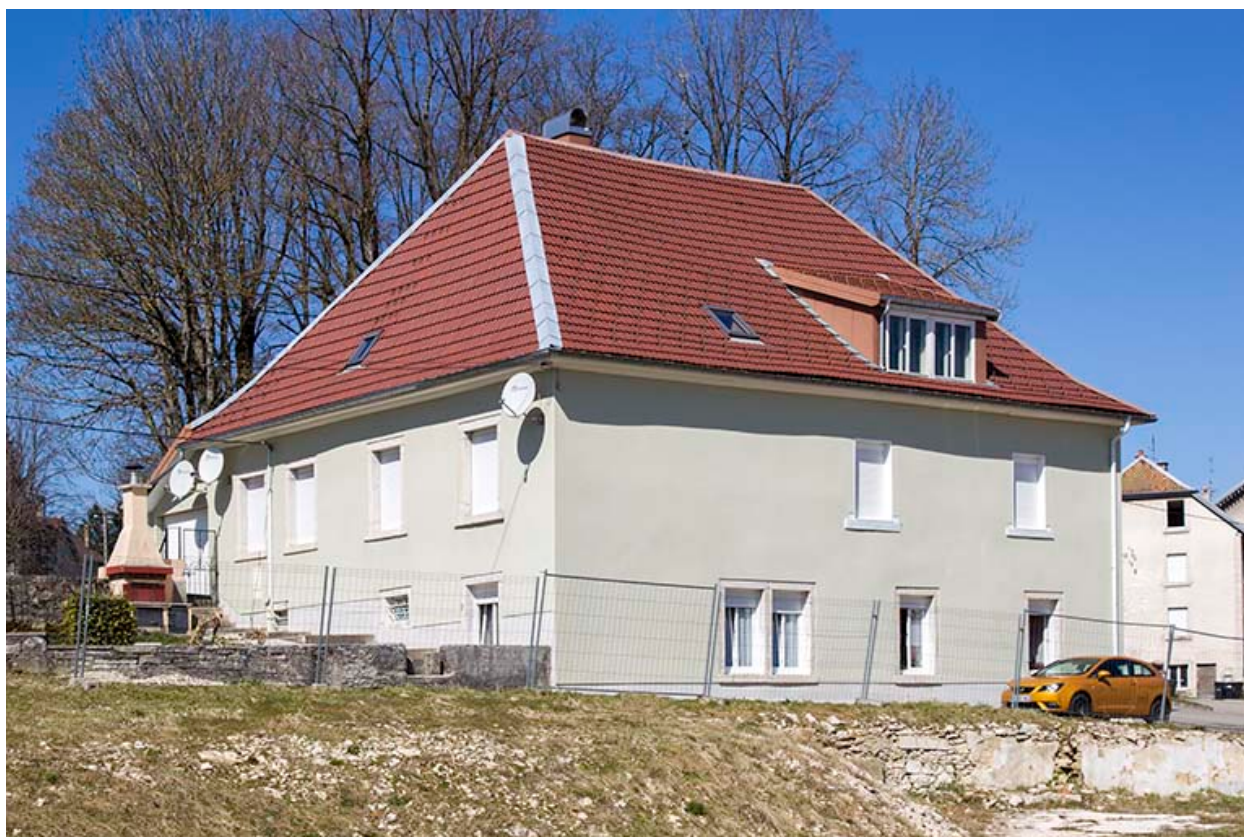
Façades postérieure et latérale droite.
