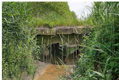
Ponceau, vue rapprochée.
