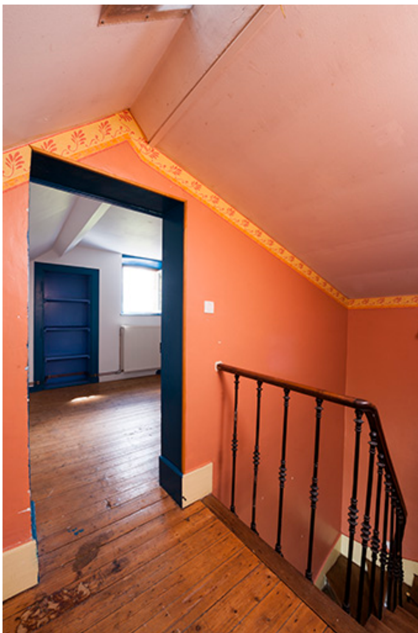
Palier de l'étage, maison du barragiste.
