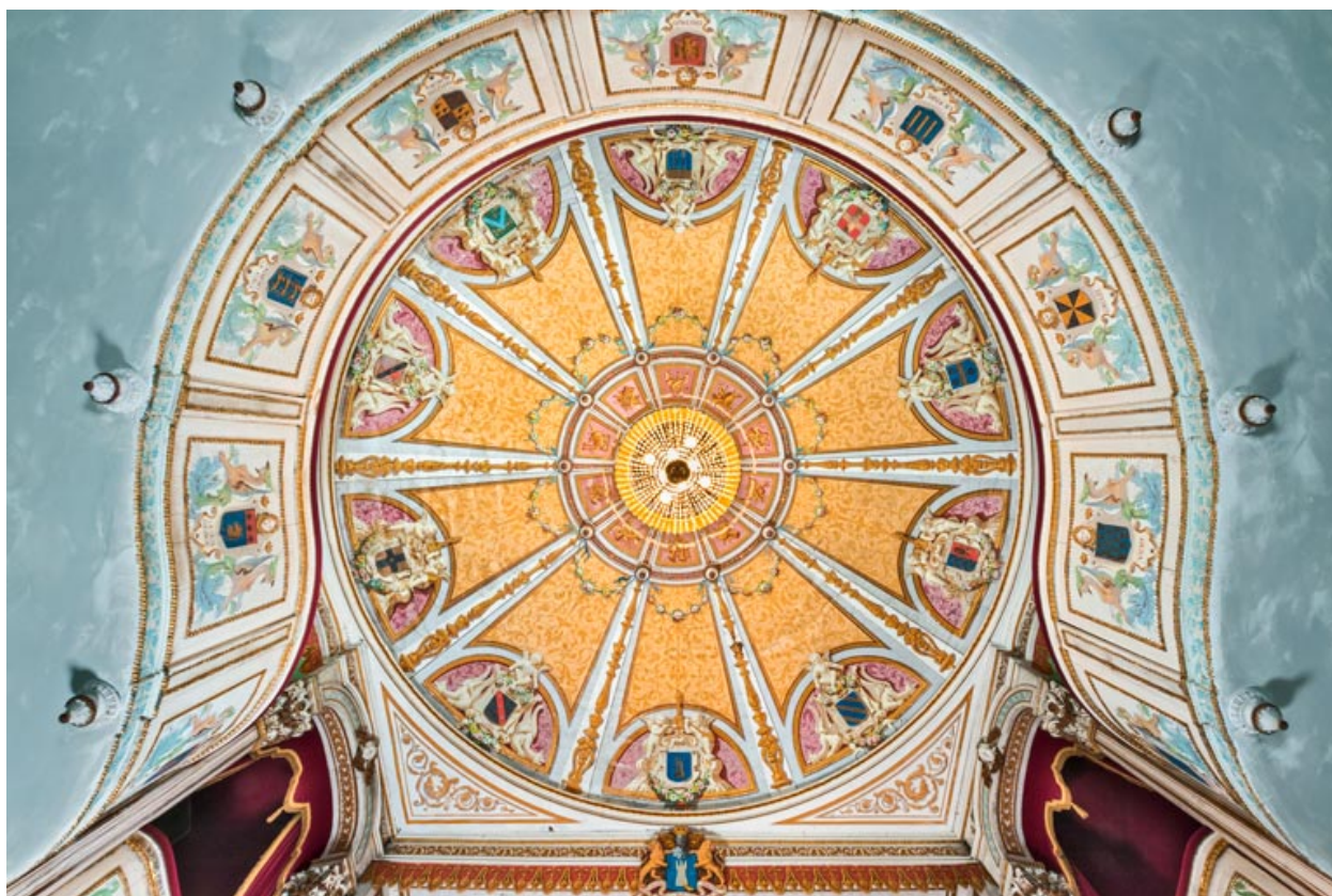
Plafond : vue d'ensemble.
