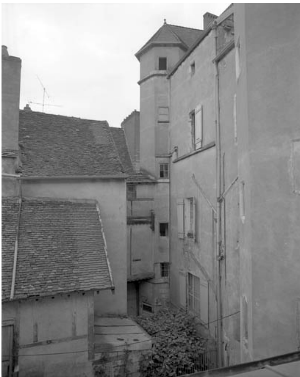
Façade postérieure depuis l'arrière-cour du 99 Grande rue.
