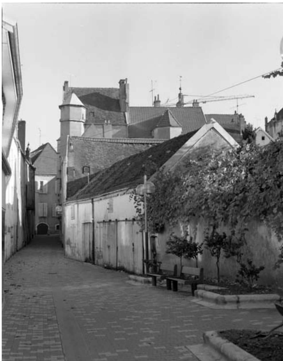
Façade postérieure depuis la rue de l'Abreuvoir.
