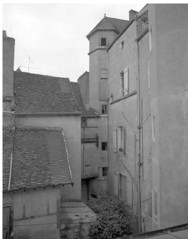
Façade postérieure depuis l'arrière-cour du 99 Grande rue.
