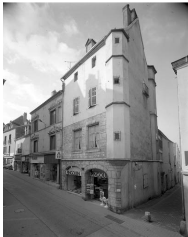
façades antérieure et latérale droite.
