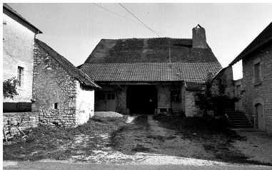
Vue principale. Phot. Bernard Lardière IVR43_19797000124Z
