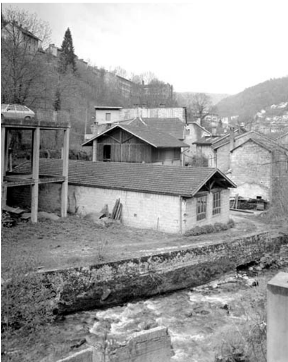
Atelier de fabrication de 1941 depuis le nord-est.
