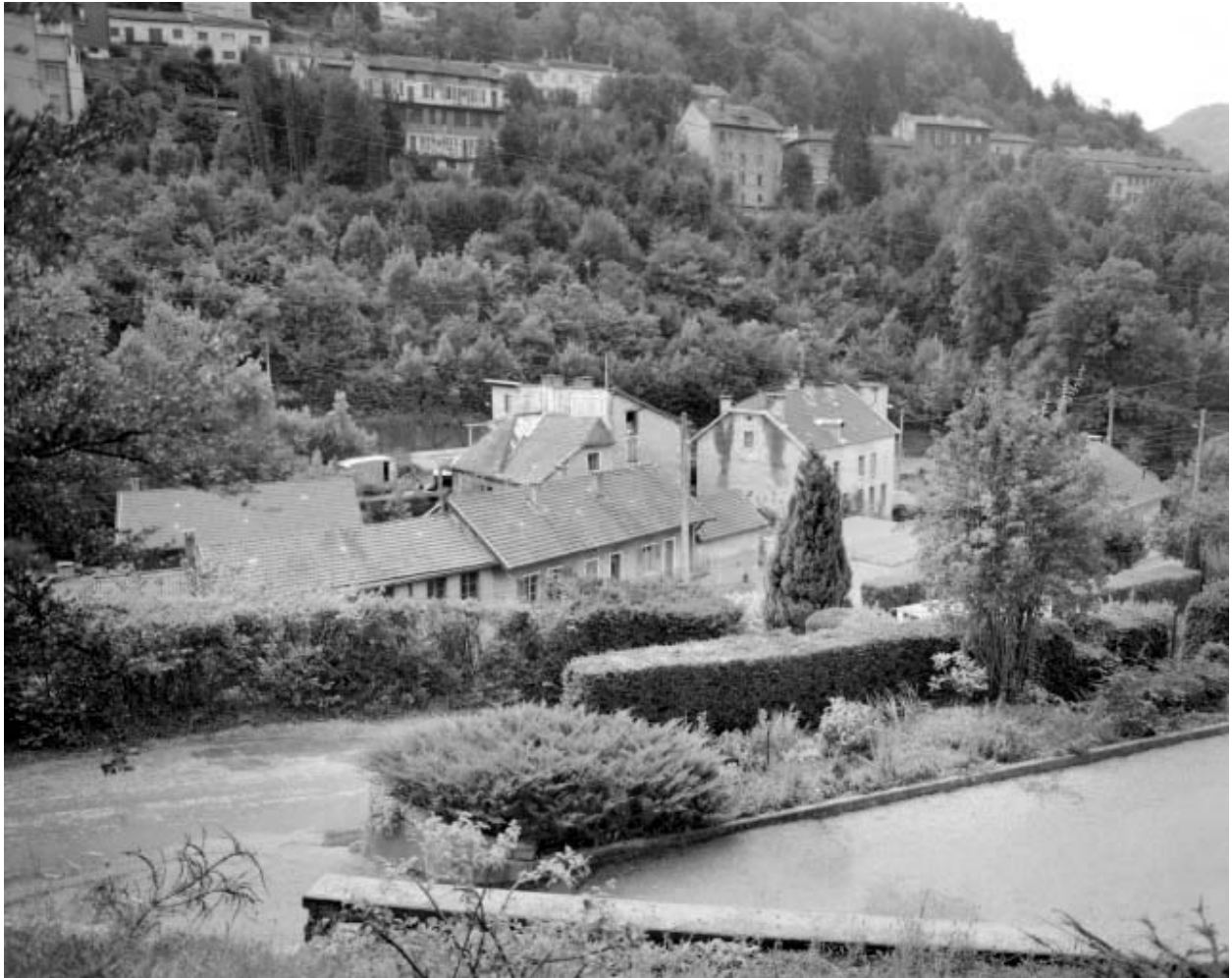
Vue d'ensemble plongeante depuis le nord-ouest.
