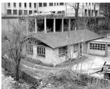
Atelier de fabrication et chaufferie de 1941. Phot. Jérôme Mongreville IVR43_19923900357X
