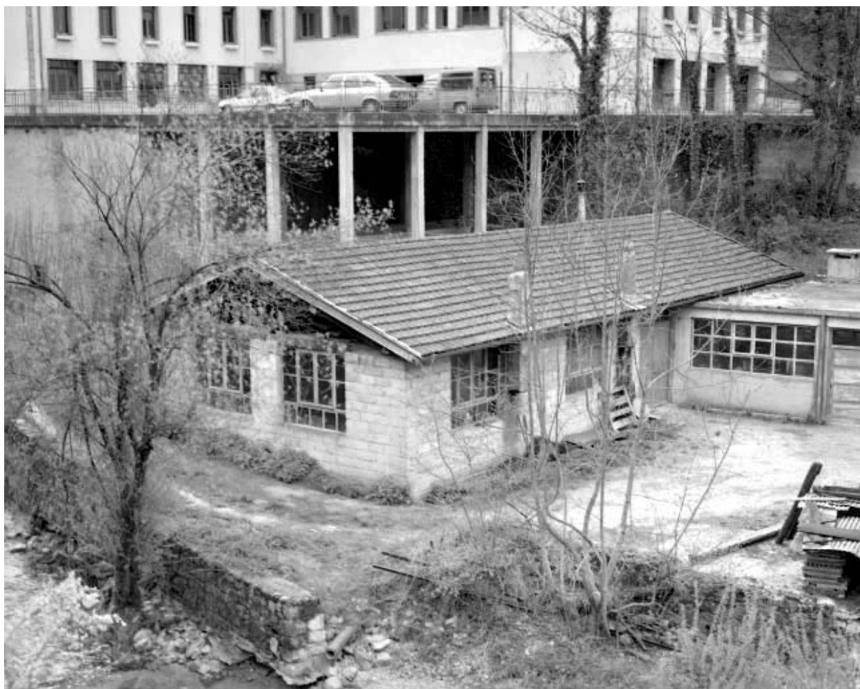
Atelier de fabrication et chaufferie de 1941.
