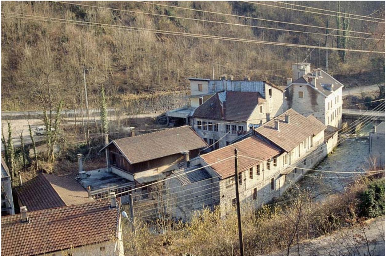
Vue d'ensemble plongeante depuis le nord-ouest.
