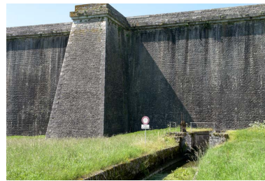
Face avant du barrage avec un contrefort et la rigole d'alimentation du canal. Phot. Alain Morelière IVR26_20072106065NUC2A
