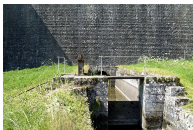
Sortie d'eau au pied du barrage et départ de la rigole d'alimentation du canal. Phot. Alain Morelière IVR26_20072106067NUC2A
