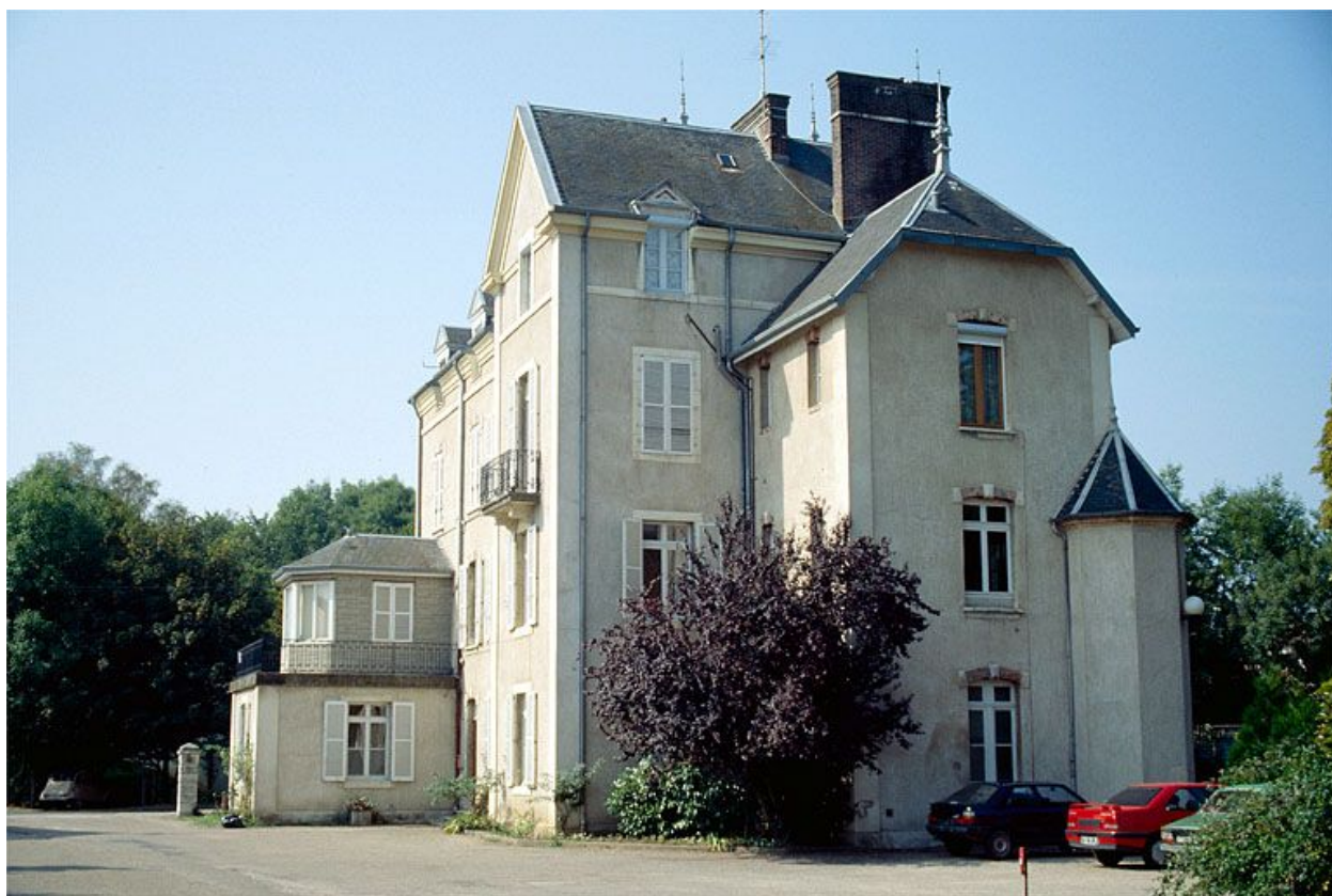
Façade latérale gauche du logement patronal (A).
