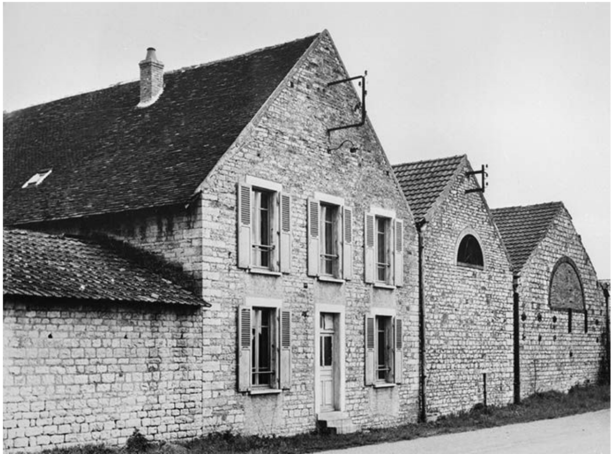
Façade antérieure du bâtiment (J).
