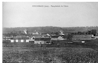
Foucherans (Jura). - Vue générale des Usines.
