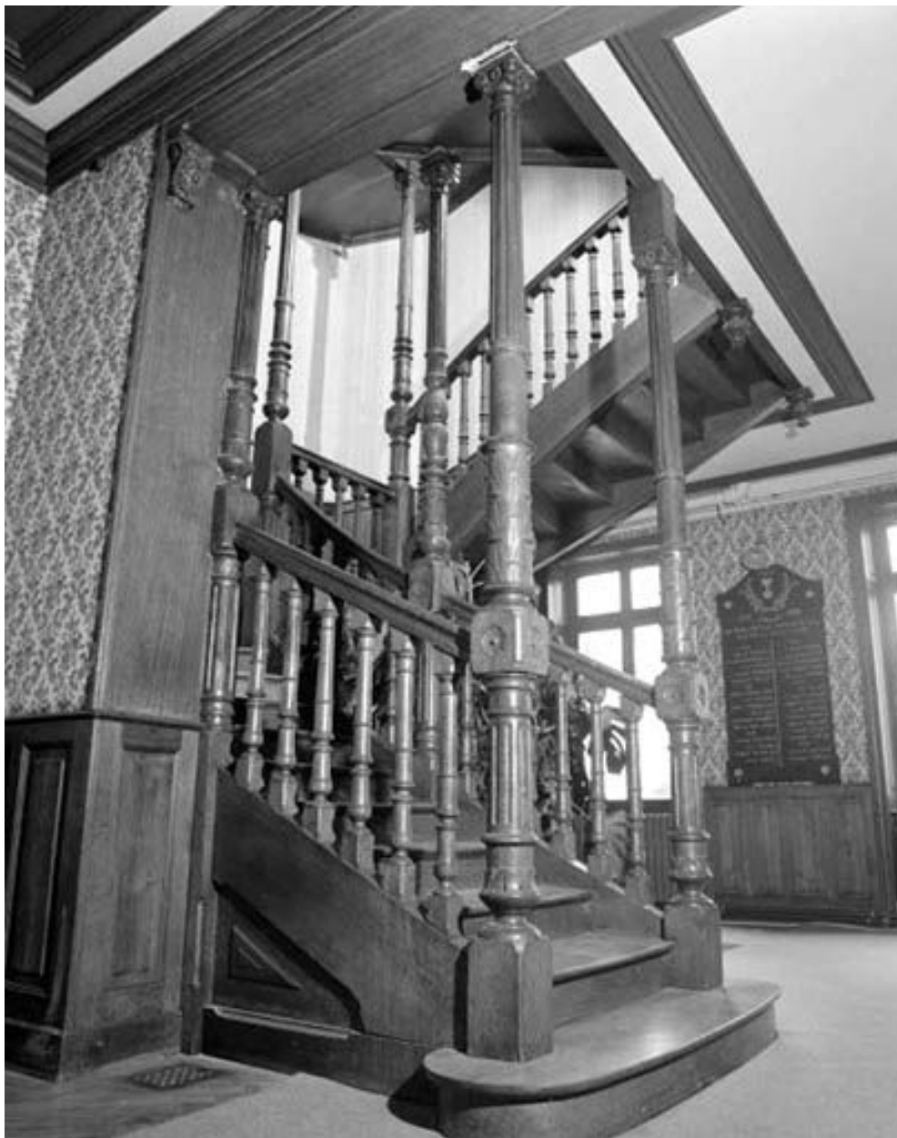
Logement patronal (A) : escalier dans-oeuvre.
