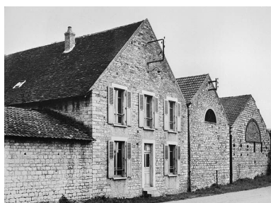
Façade antérieure du bâtiment (J).
