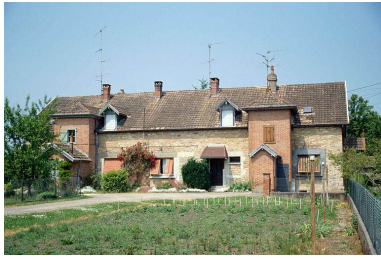
Logement de contremaître (Y) vu de face. Phot. Laurent Poupard IVR43_19893900643ZA
