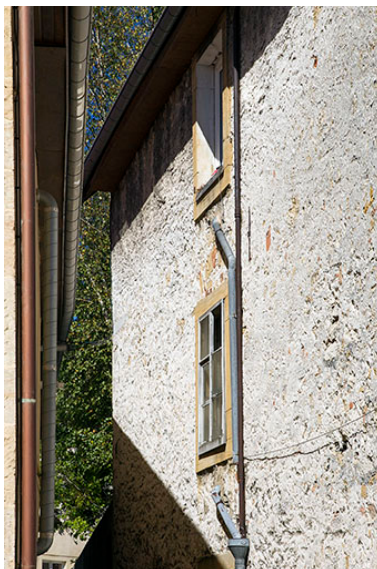
Baies sur le mur ouest.
